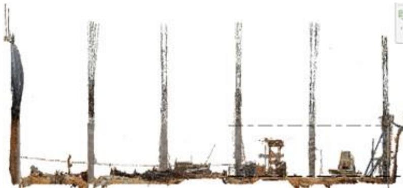
Figura 6. (a) Columnas en estudio del eje cuatro (b) vistas de frente (c) del 09 de marzo de 2017.
