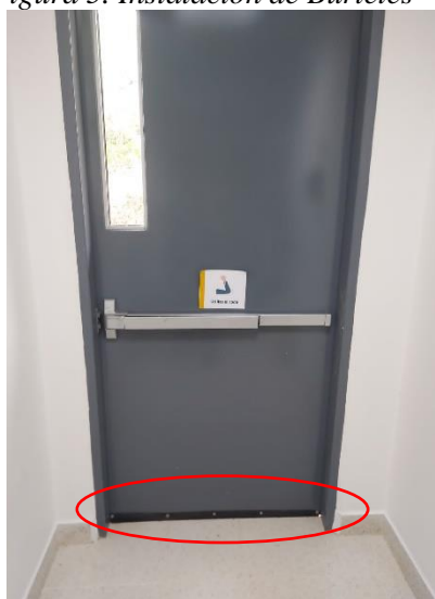
Figura 5. Instalación de Burletes
