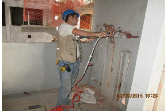
Figura 16. Prueba de hermeticidad a red de gas
