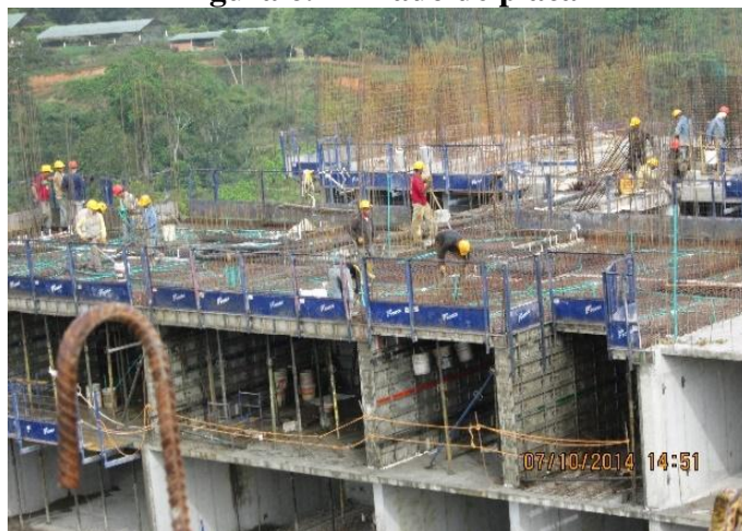
Figura 6. Armado de placa
