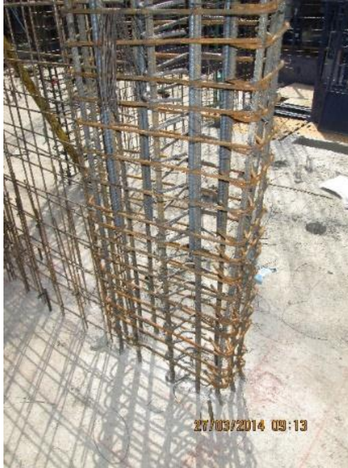
Figura 4. Acero de refuerzo, pinado y cimbrado
