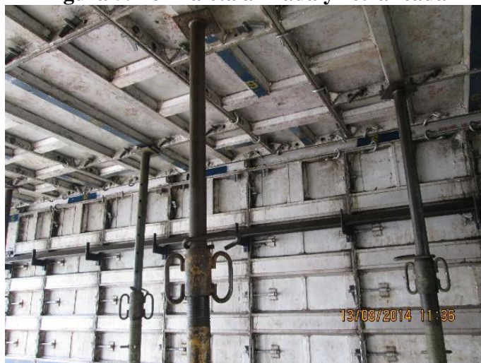
Figura 5. Formaleta armada y retrancada
