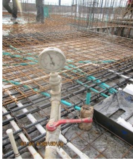
Figura 14. Prueba de presión a red hidráulica antes de fundir
