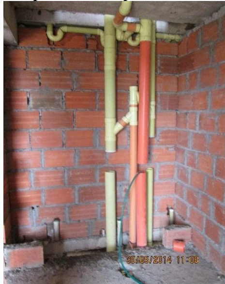
Figura 15. Llenado de tubería para realizar prueba de estanqueidad a red sanitaria
