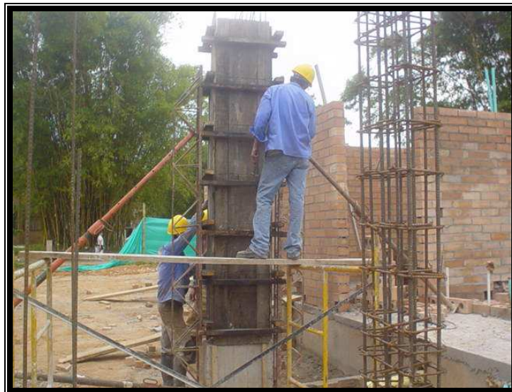
FIG. 28 Formaleteado Columnas
