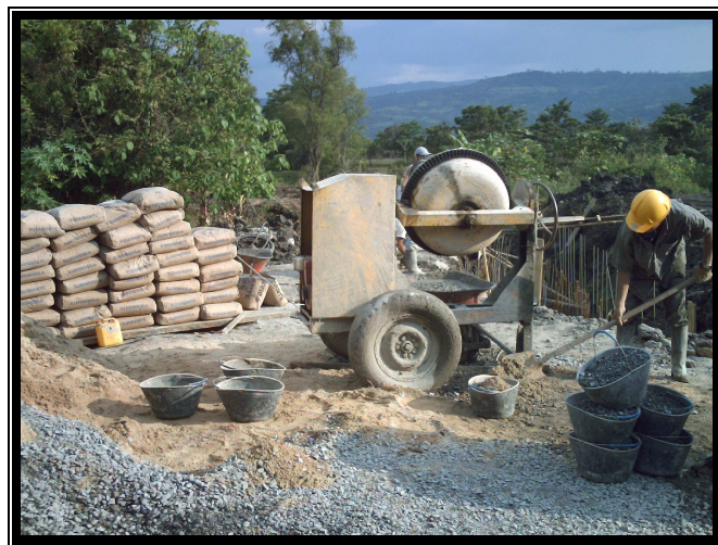
FIG. 22. Mezclado Cemento
