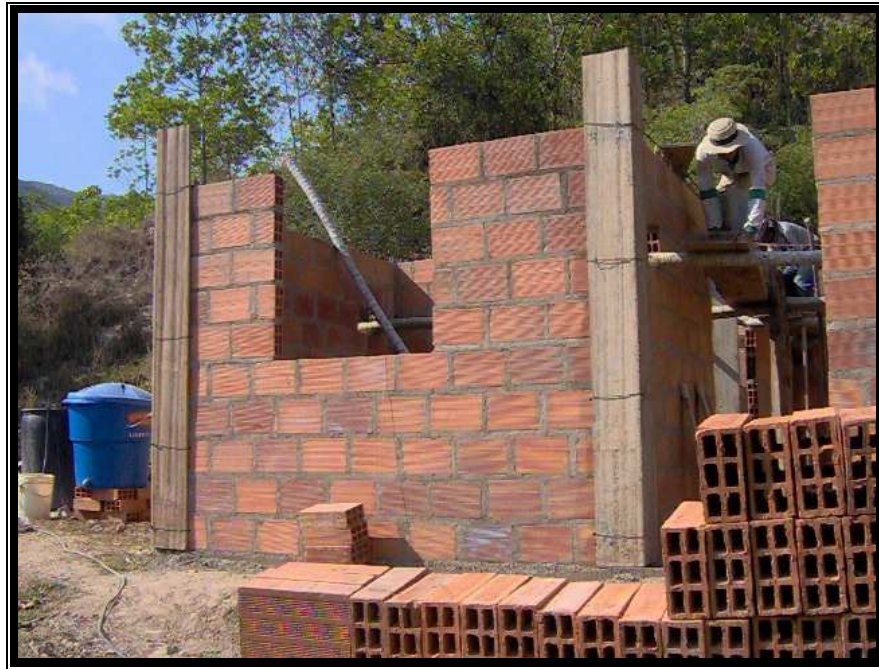
FIG. 30. Construcción Casa Interés Social
