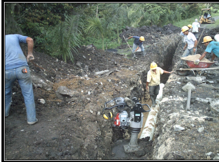
FIG. 10. Excavación Manual
