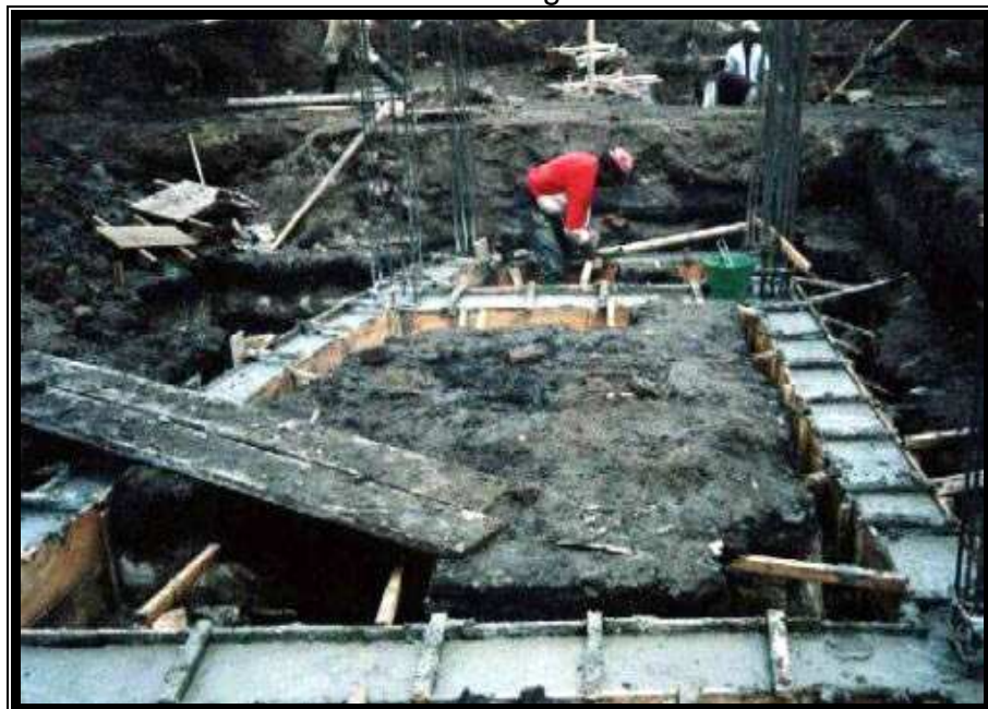
FIG. 33. Formateado Vigas de Cimentación
