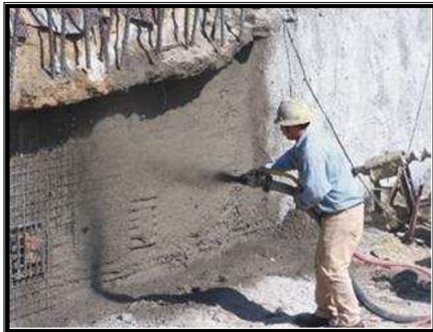
FIG. 34. Concreto Lanzado
