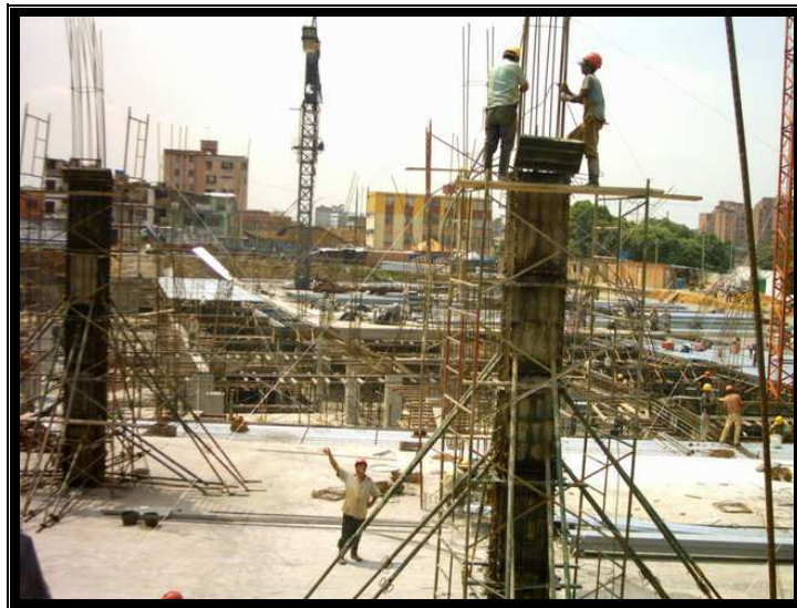
FIG. 27. Armado Columnas
