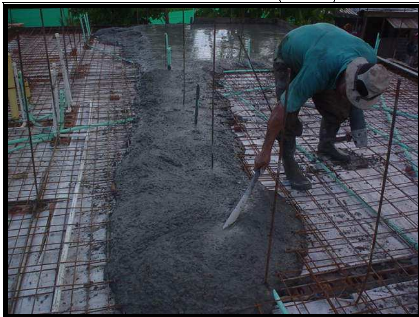
FIG. 24. Vaciado Concreto (Manual)
