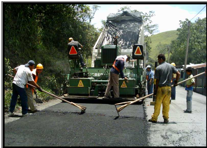
FIG. 15. Extendida Mezcla Densa
