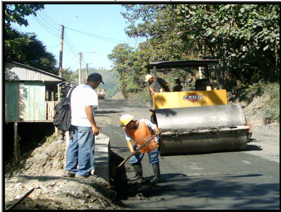
FIG. 18. Compactación Carpeta Asfáltica
