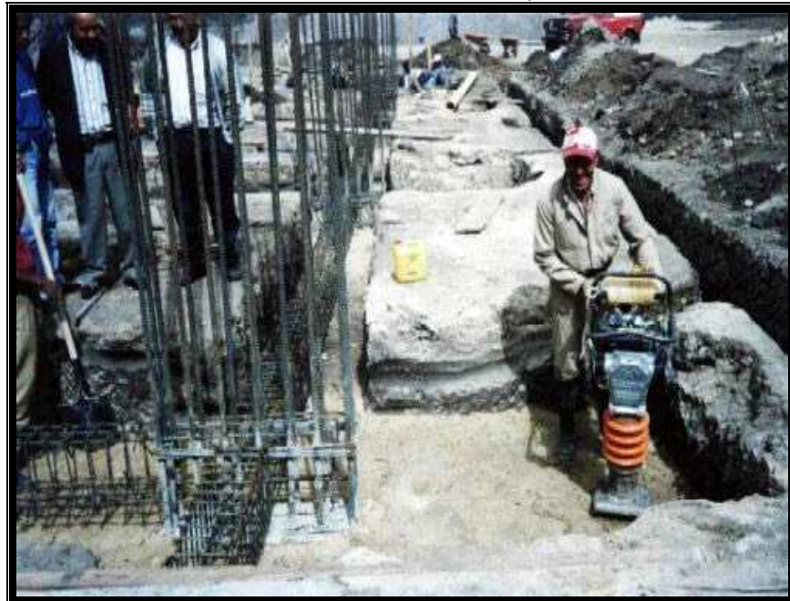
FIG. 32. Construcción Zapatas
