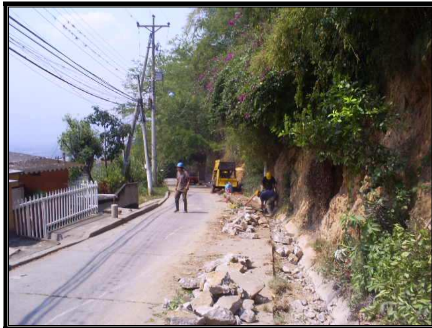
FIG. 13. Rotura de Pavimentos
