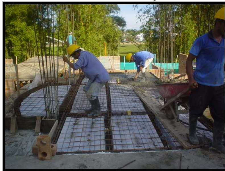
FIG. 23. Armado Placa Aligerada
