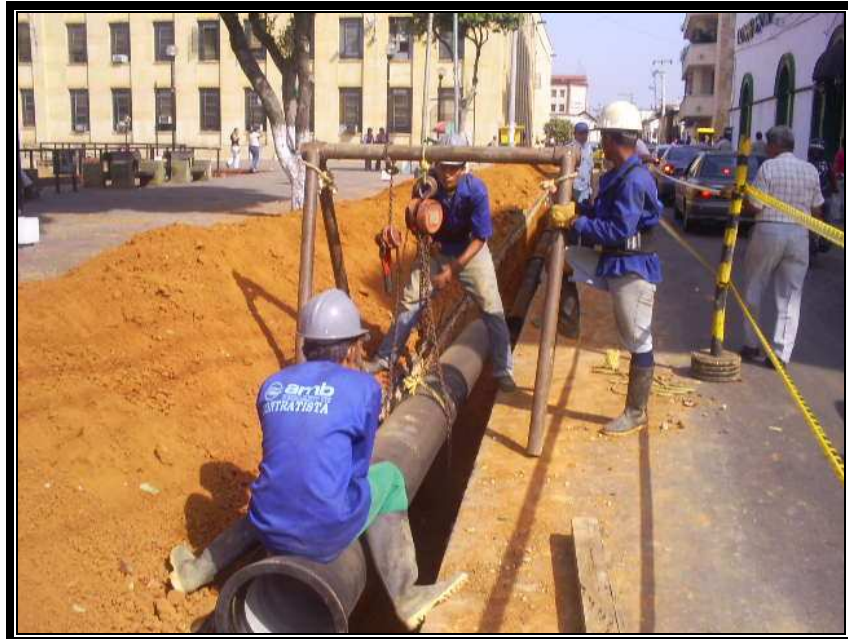
FIG. 12. Instalación Tubería
