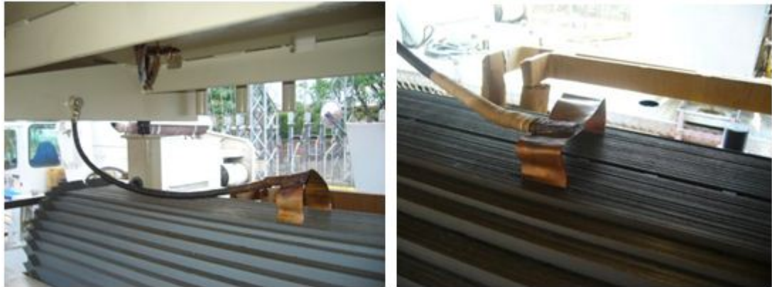
Figura 3.11: Aterrizaje del núcleo Fuente: Autora del Proyecto
