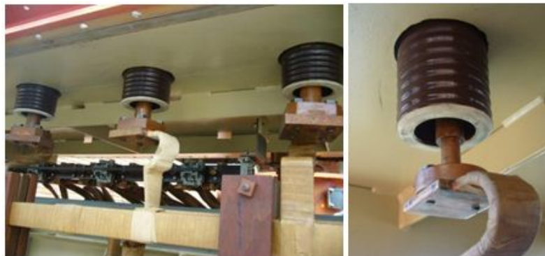
Figura 3.30: Vista Interna del Aislador Pasatapas Fuente: Autora del Proyecto
