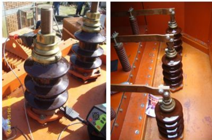
Figura 3.29: Vista Externa del Aislador Pasatapas Fuente: Autora del Proyecto
