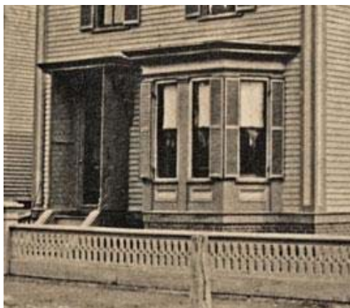
Figura 228: Sede original de la primera Iglesia de Cristo Científico.
