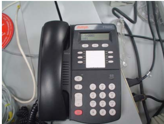
Figura 1-18. Teléfono Modelo 4606IP (Fuente: Fotografía tomada por el autor)
