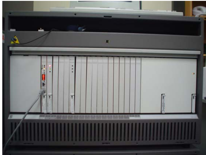
Figura 1-27. Gabinete tipo SCC de expansión (Fuente: Fotografía tomada por el autor)
