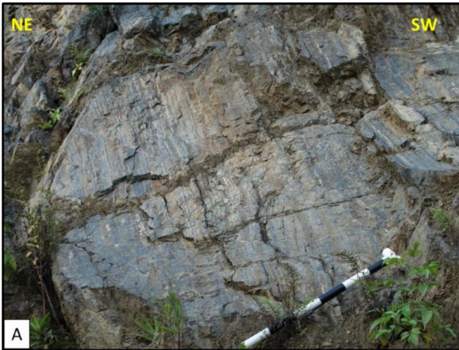
Figura 10 Fotografía representativa del segmento B, (A) Fotografía del bastón No 14, el bastón representa 1.5 m, se evidencian tobas vítreas con laminación plano paralela altamente fracturadas y meteorizadas.
