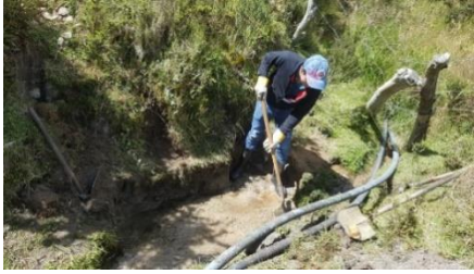
Figura 3. Adecuación del terreno
