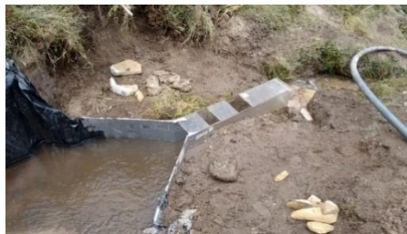
Figura 4. Adecuación final del vertedero
