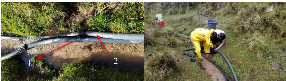
Figura 12. Detalle extracción E3
