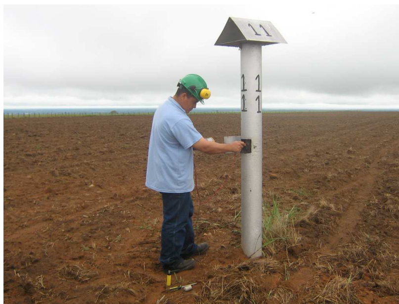
Figura 12. Poste para toma de potencial en el tramo Apiay- Bogotá.
