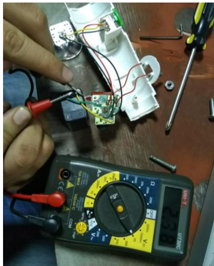
Fotografía 15. Circuito para recarga de batería.
