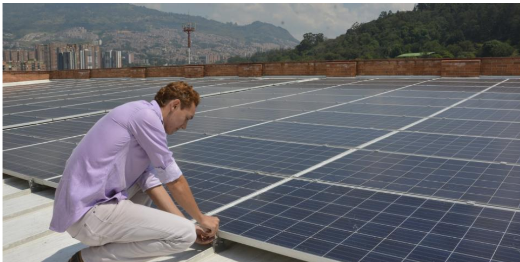
Figura 4. Instalación Panel Solar.
