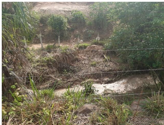
Figura 4. Punto de ocupación de cauce para la construcción de un Box Culvert sobre la quebrada las Nieves.
