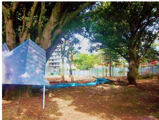
Figura 6. Predio para la construcción del proyecto Torre Vitro constructora MARVAL.
