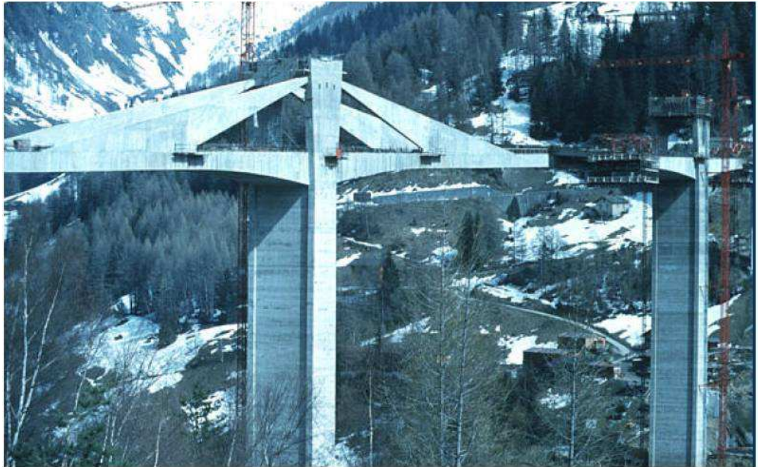
Figura 1. Puente Ganter en etapa de construcción, Suiza (1980)
