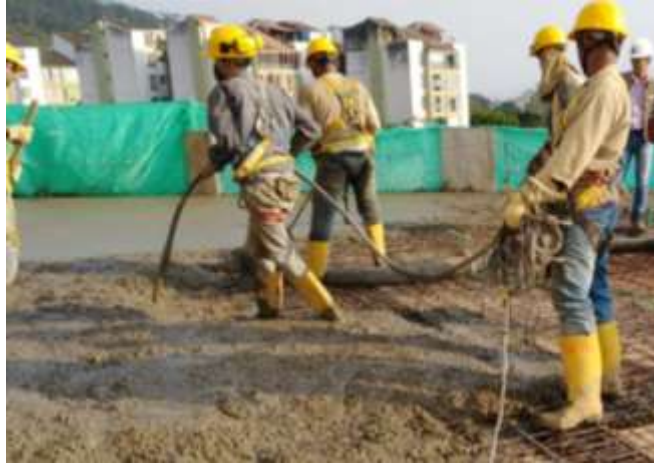
Figura 16. Vibrado del concreto en obra. Nota. Tomado de: INSUT SAS.
