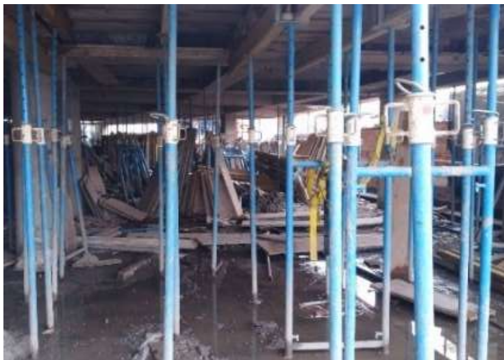
Figura 18. Apuntalamiento temporal. Nota. Tomado de: INSUT SAS.
