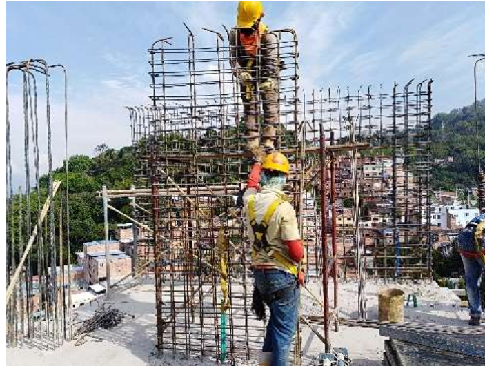
Figura 19. Armado de elementos estructurales. Nota. Tomado de: INSUT SAS.
