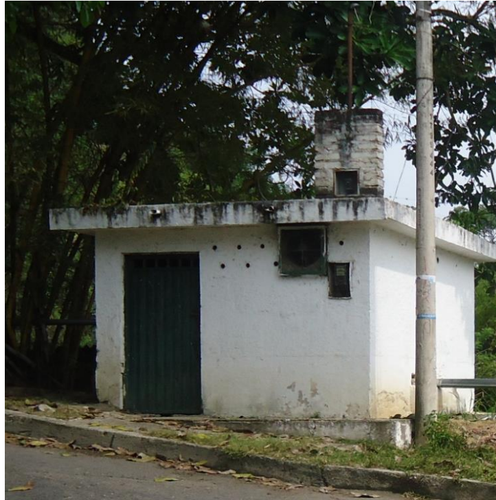
Figura 16. Estación de bombeo
