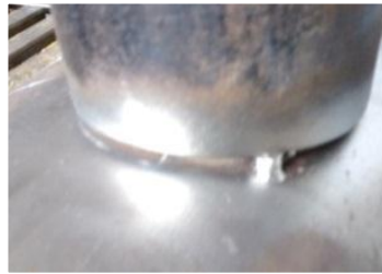
g. Estado inicial para soldadura
