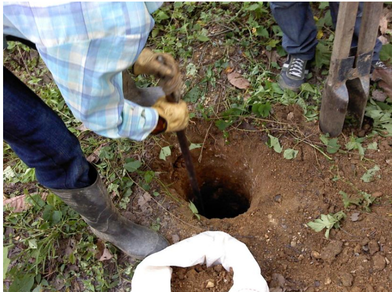
Figura 7 Apiques realizados en el terreno.
