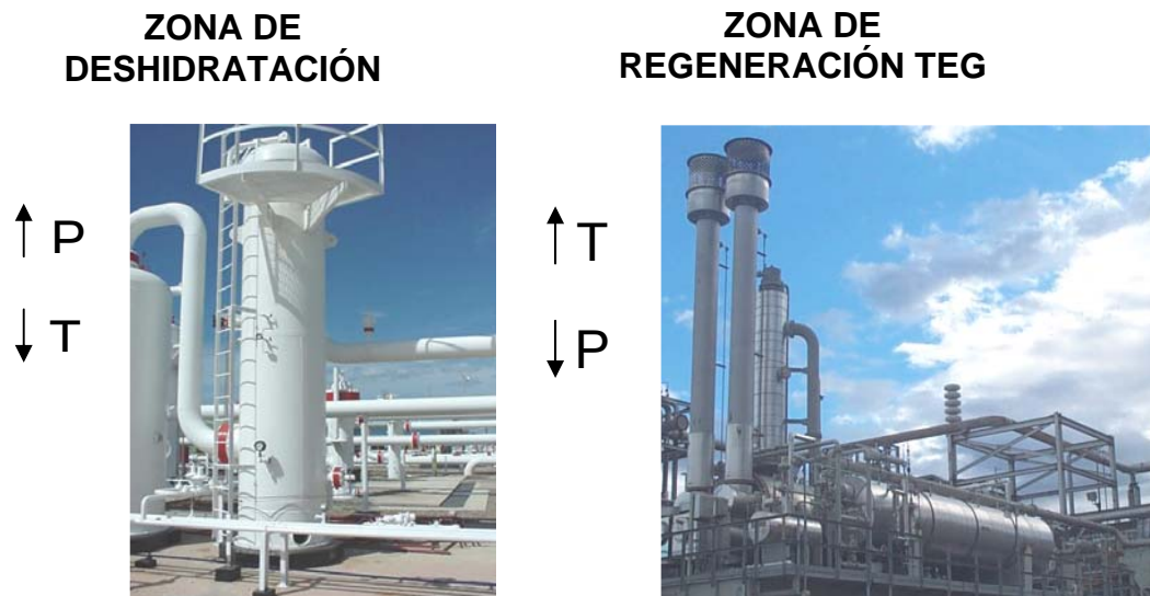
Figura 1.2: Secciones del Proceso de Absorción.
