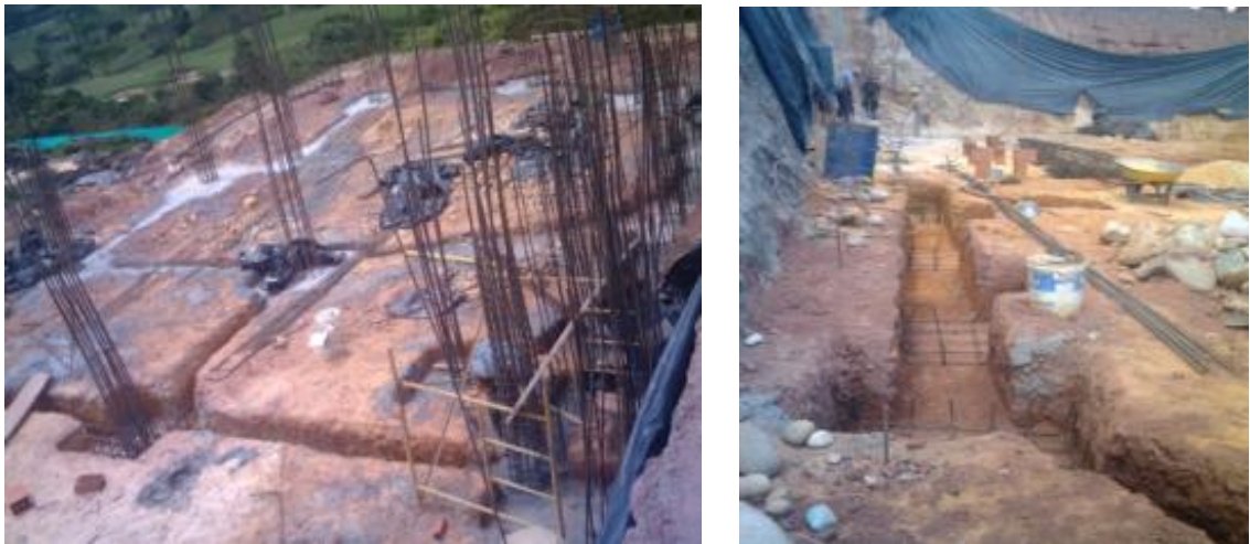
Figura. 28 cimentación local zona de caddies
