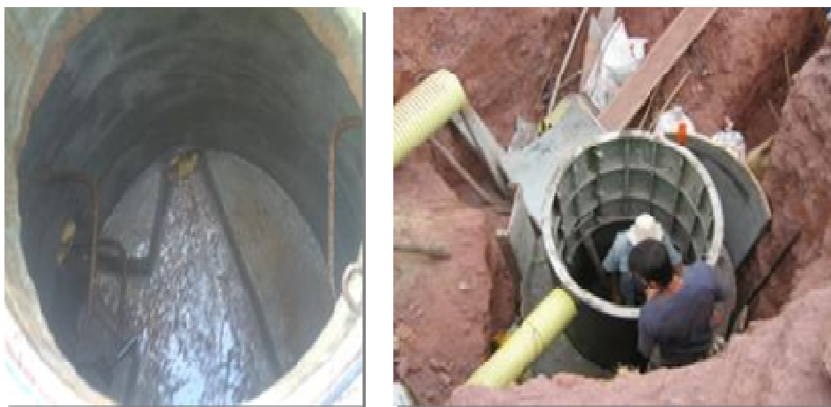
Figura. 20 Construcción cilindro pozo de inspección y cañuelas Aldea Comercial.
