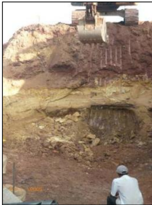
Figura. 64 Excavación y replanteo de pisos.
