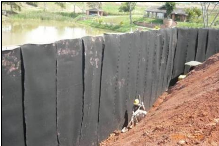
Figura. 74 Instalación de geodren planar.
