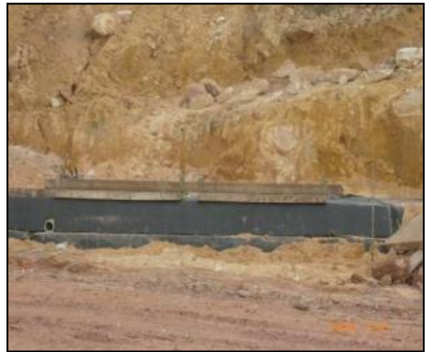
Figura. 14 Muro de tierra armada Náutica.
