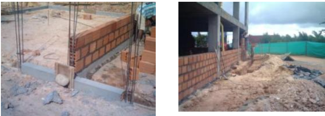
Figura. 32 colocación de mampostería oficinas y locales
