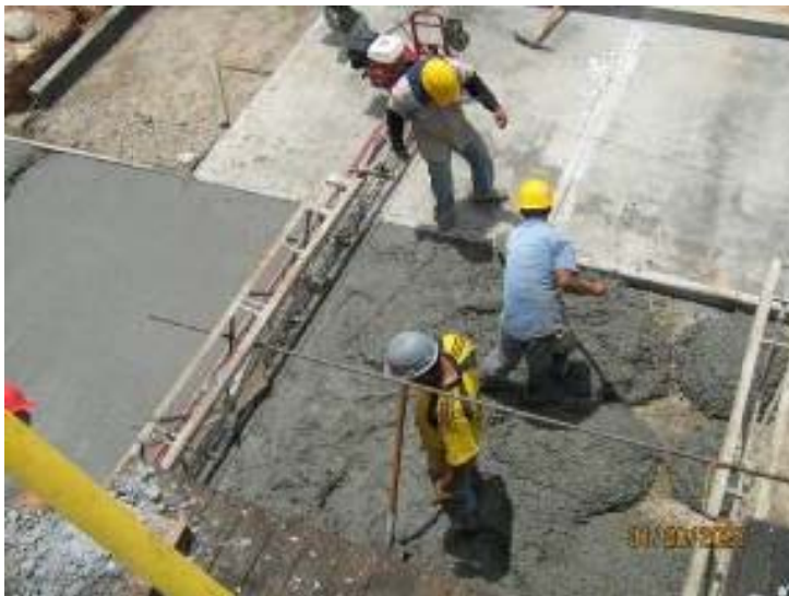
Figura. 24 Regla vibratoria de pavicrete.
