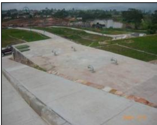
Figura. 3 Tanque de almacenamiento pradera.
