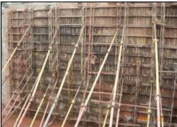
Figura. 70 Encofrado pantalla
