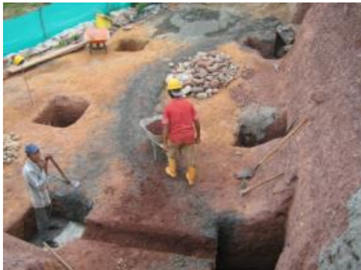
Figura. 27 pilotes para cimentación zona de caddies
