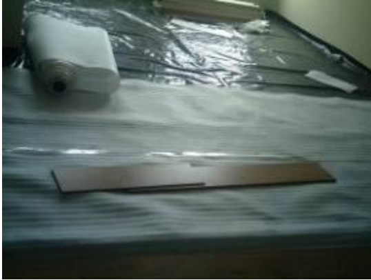
Figura .35 Colocación piso en madera.
