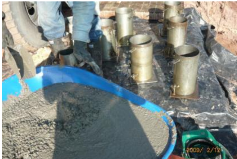
Figura. 44 Toma de muestras de concreto.
