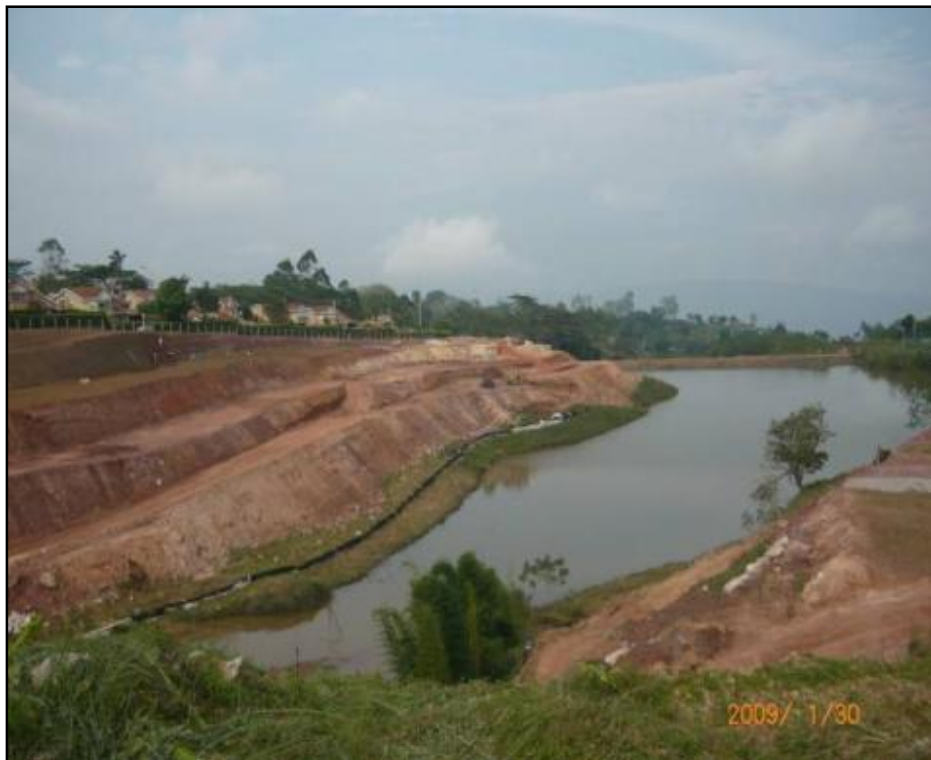
Figura. 10 Movimiento de tierras zona cabañas Náutica.
