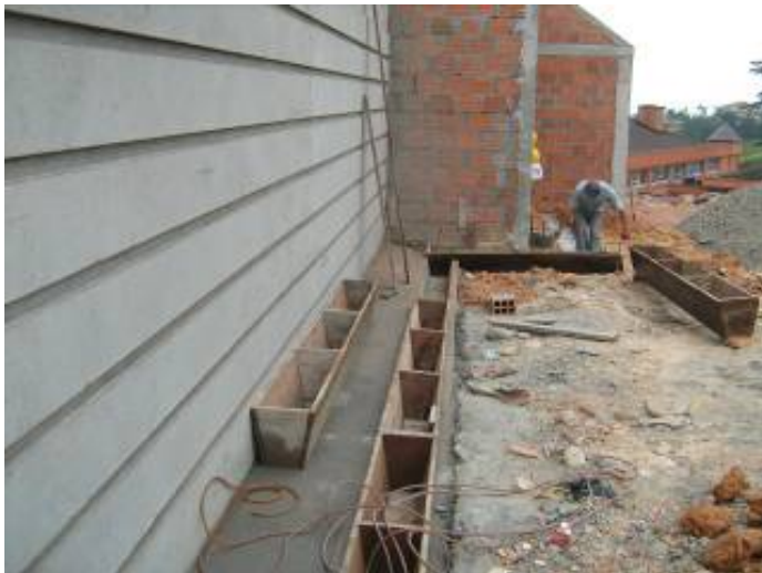
Figura .21 construcción de canaleta Aldea Comercial.
