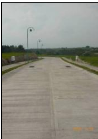
Figura. 5 Losas de pavicreto la pradera.
