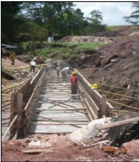
Figura. 13 Box Culvert Náutica.
