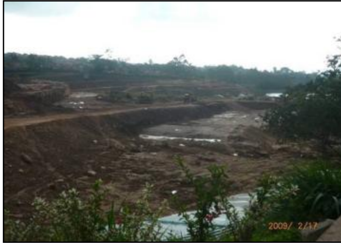
Figura. 11 Movimiento de tierras zona lotes.
