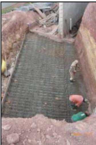
Figura. 65 Armado de base.
