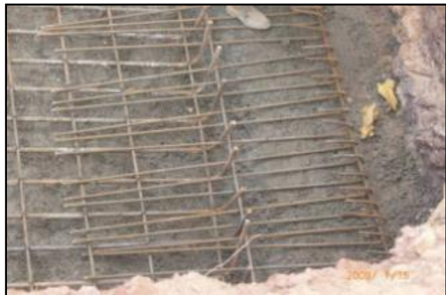
Figura. 66 Refuerzo del tacón.
