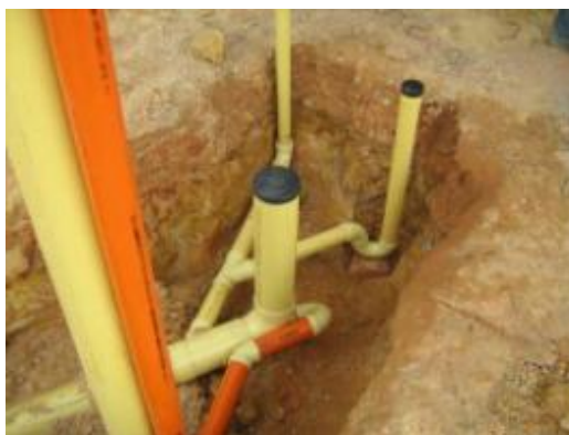
Figura. 40 Detalles araña de red Sanitaria
