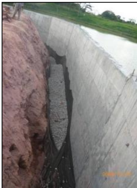
Figura 72 Construcción filtro.
