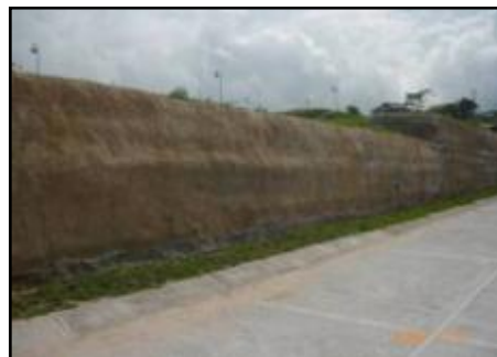
Fig. 2 Muros en tierra armada de pradera.
