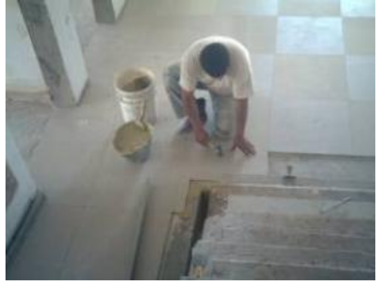
Figura. 36 Colocación porcelanato.
