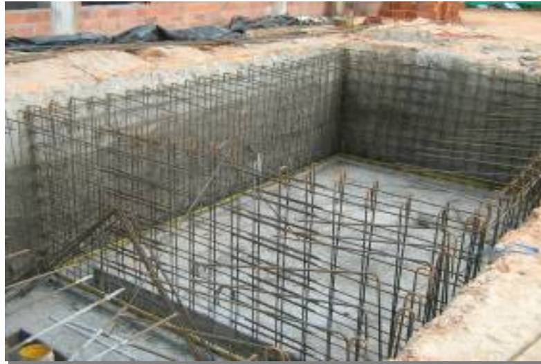
Figura. 22 Construcción tanque de almacenamiento Aldea Comercial.
