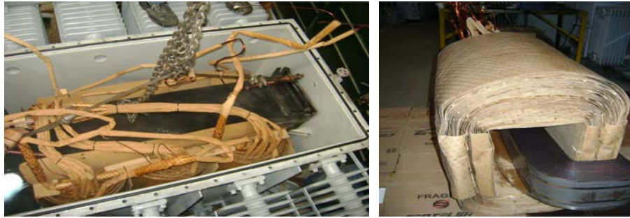
Figura 4. Disposición de papel Kraft en bobinas y en cableado interno.
