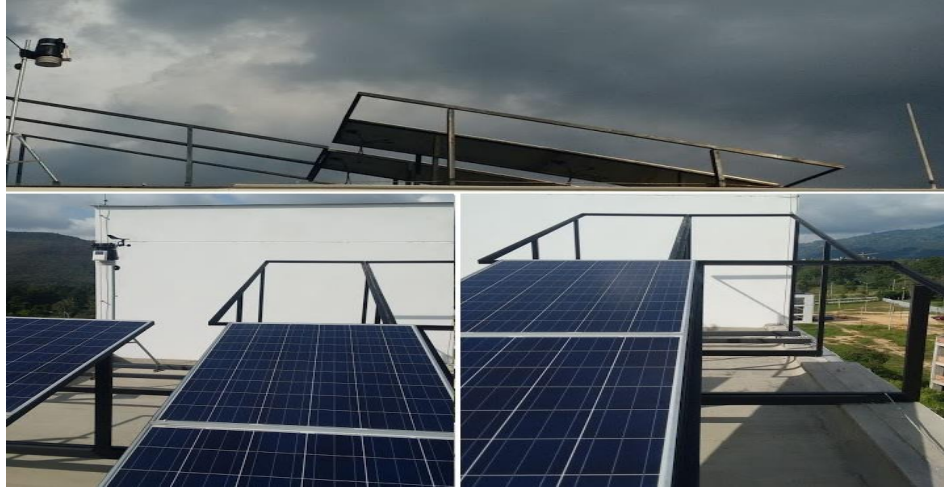
Figura 10. Instalación Paneles fotovoltaicos.
