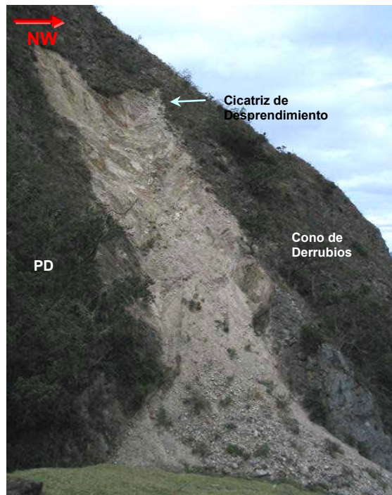
Foto 25. Cono de derrubios sobre el Ortoneis al Oeste aguas abajo de la Quebrada El Chorreron, ligada a esta forma también se presenta en la parte superior del cono una cicatriz de desprendimiento.
