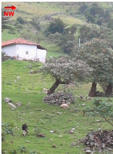
Foto 27. Procesos de reptación, identificándose por la inclinación de los árboles. Predios de la finca Agua Blanca.
