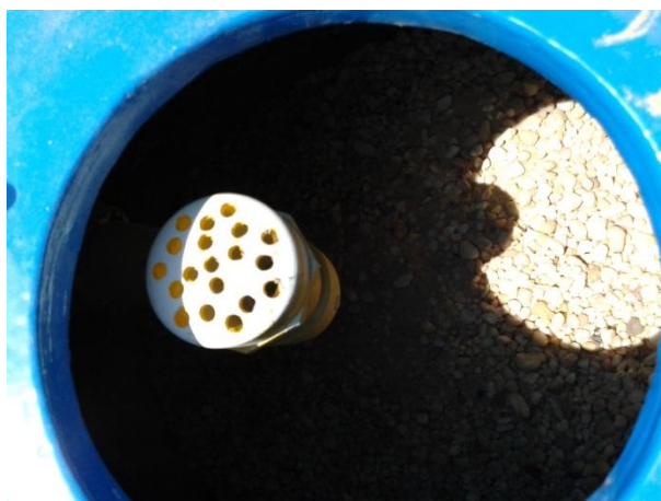
Figura 42. Introducción de grava
