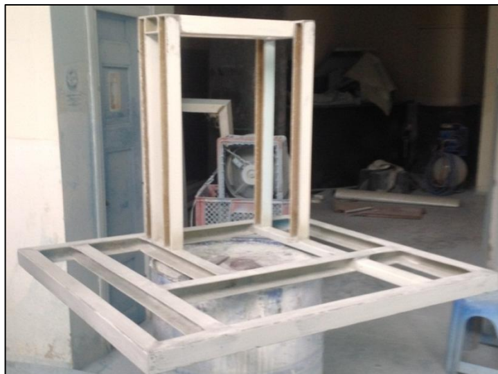
Figura 13. Construcción de la estructura
