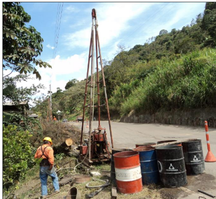
Fotografía 13. Detalle de Sondeo No. 2
