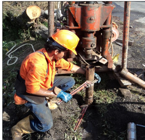
Fotografía 15. Detalle de revestimiento Sondeo No. 4
