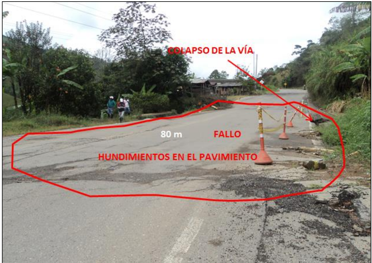
Fotografía 2. Panorámica sector PR 44 + 950
