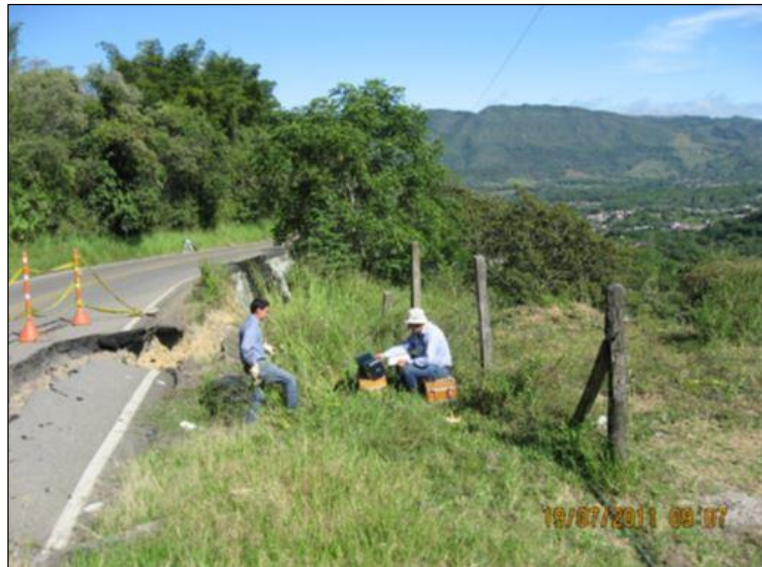
Fotografía 16. Sondeo Eléctrico Vertical SEV-1
