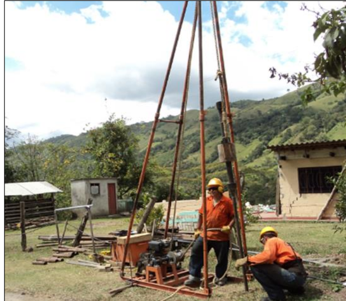
Fotografía 12. Detalle de Sondeo No. 1
