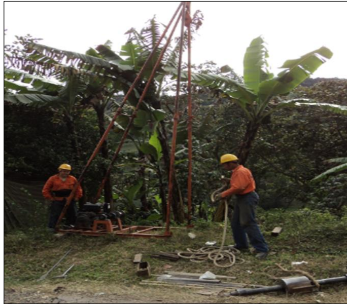
Fotografía 14. Detalle de Sondeo No. 3
