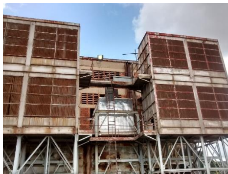
Figura 24. Sistema de Inyección Aire – Filtros Externos
