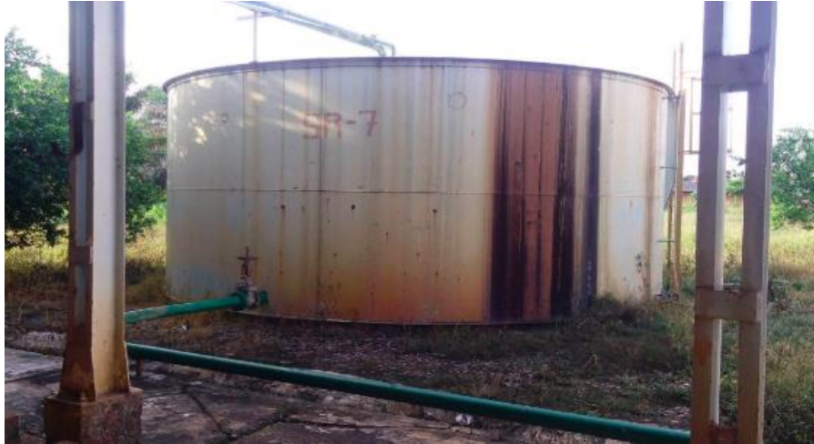
Figura 10. Tanque de Almacenamiento Agua Potable SR-7
