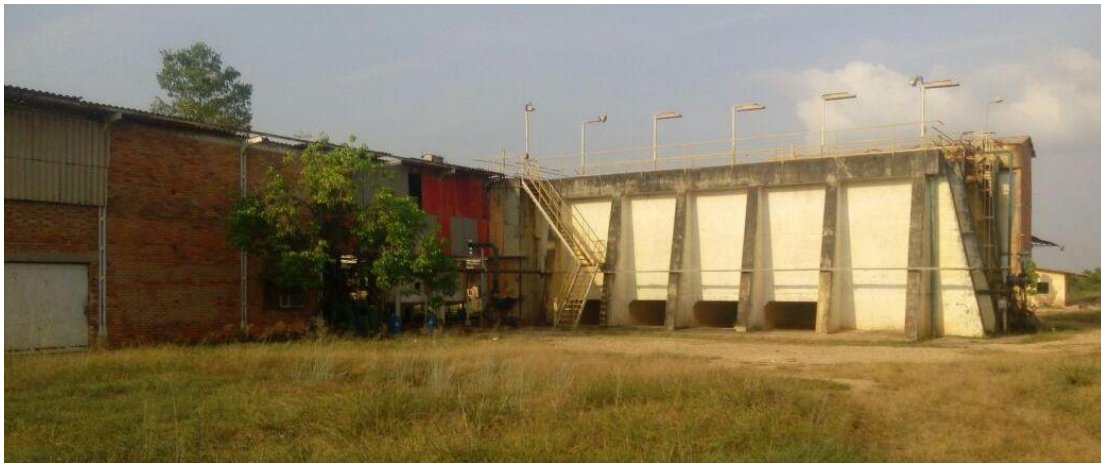
Figura 3. Planta de Tratamiento de Agua Clarificada y Potable
