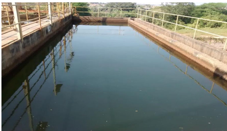
Figura 7. Alberca de Almacenamiento y Control Agua Clarificada
