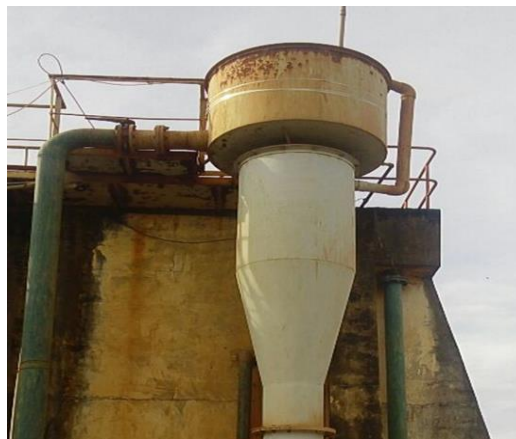
Figura 5. Mezclador de Reactivos (Sifón pulsador)
