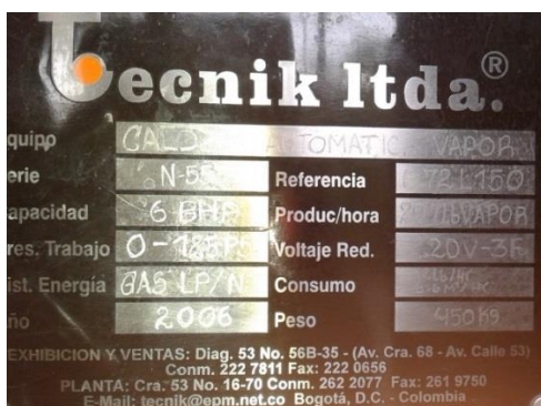
Figura 7. Caldera automática a gas EQ20.
