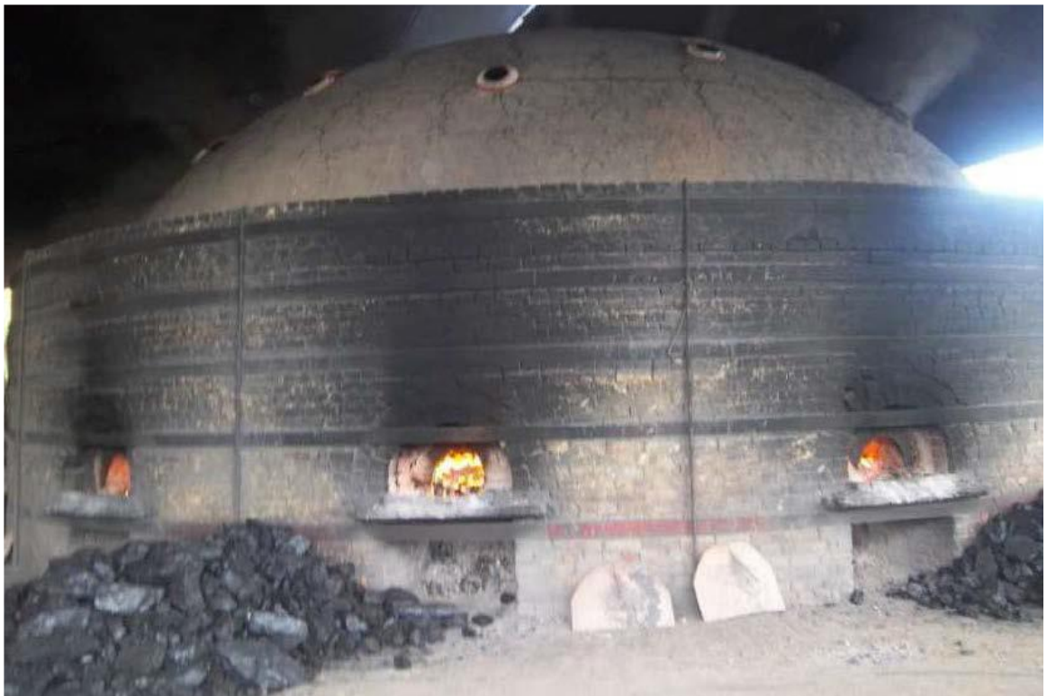
Figura 34. Horno colmena de la empresa Ladrillos y Acabados.
