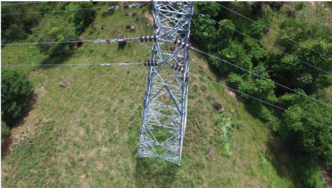
Figura 2.16: Fotografía estructura completa.
