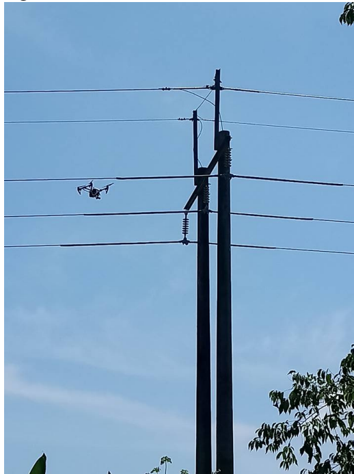
Figura 2.10: Acercamiento a la estructura.
