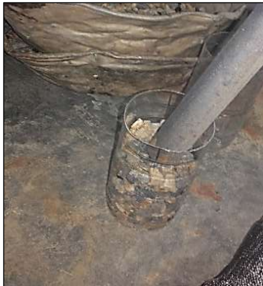
Figura 8. Compactación de relleno de botellas
