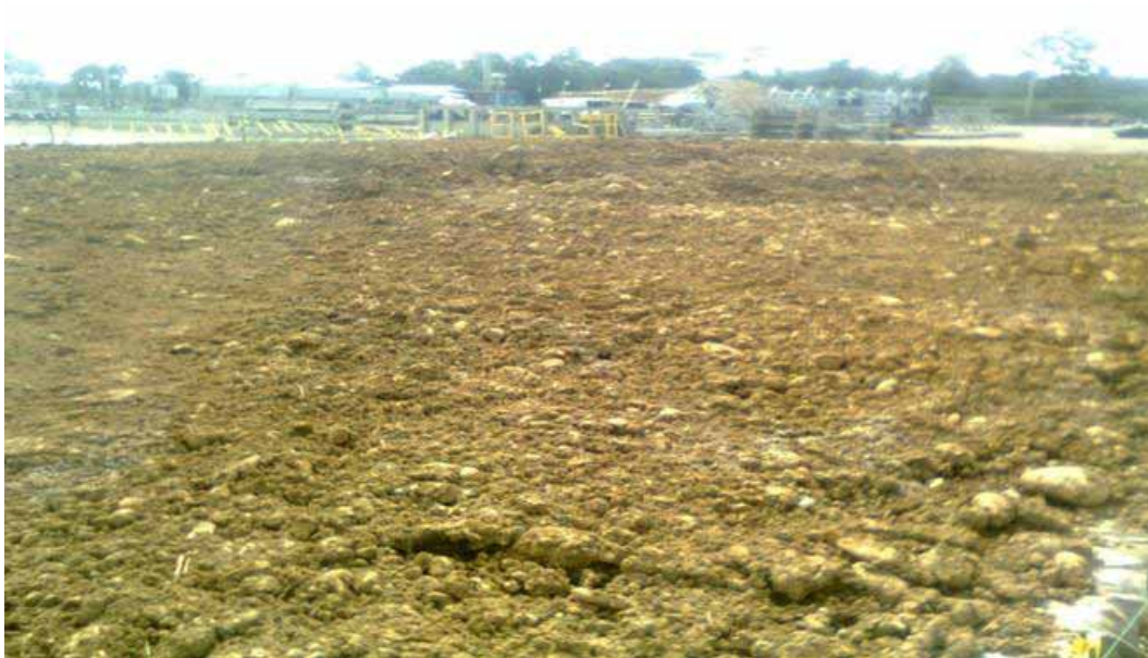
Imagen 27 zona de disposición de recortes Rig 202 Suria
