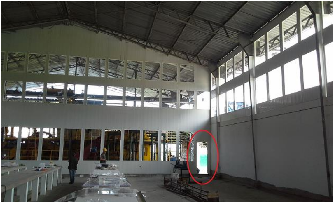
Figura 75. Cercha del cuarto de moldeo.
