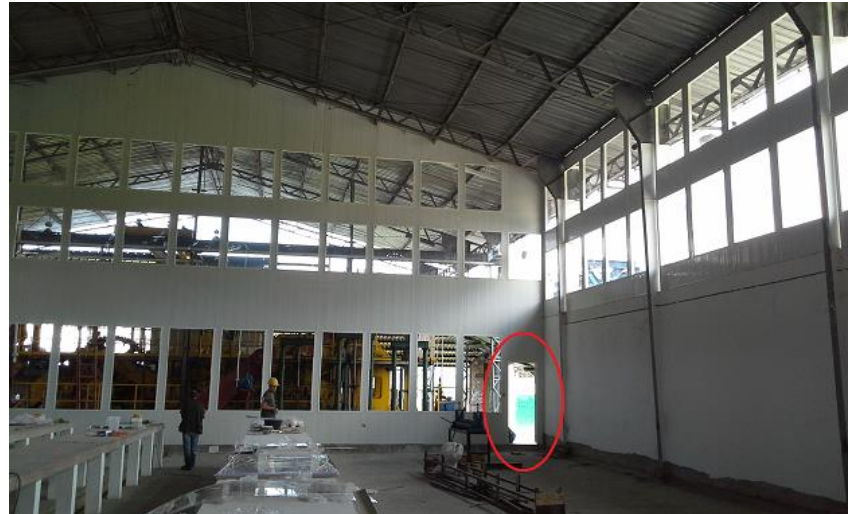
Figura 47. Vista frontal cuarto de moldeo del ingenio Mieles SA.
