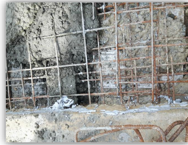
Figura 33. Aplicación de Sikadur 32 entre juntas
