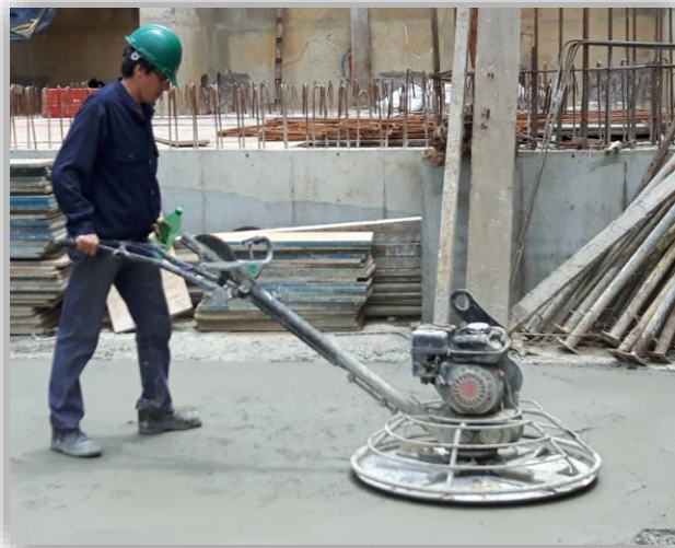
Figura 35. Allanado mecánico del concreto
