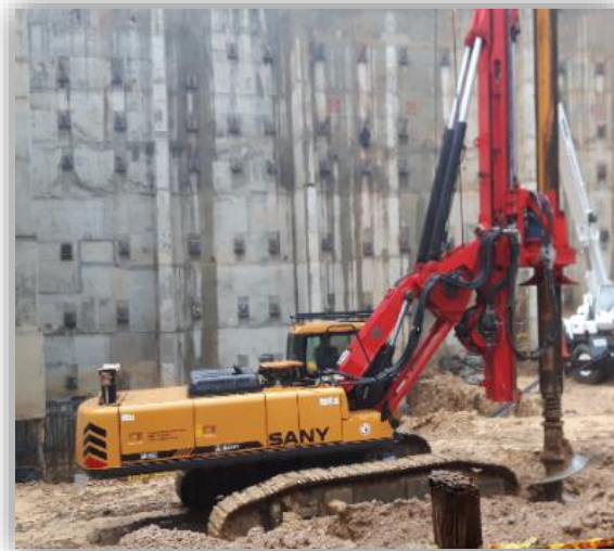
Figura 8. Máquina perforadora Sany SR150C
