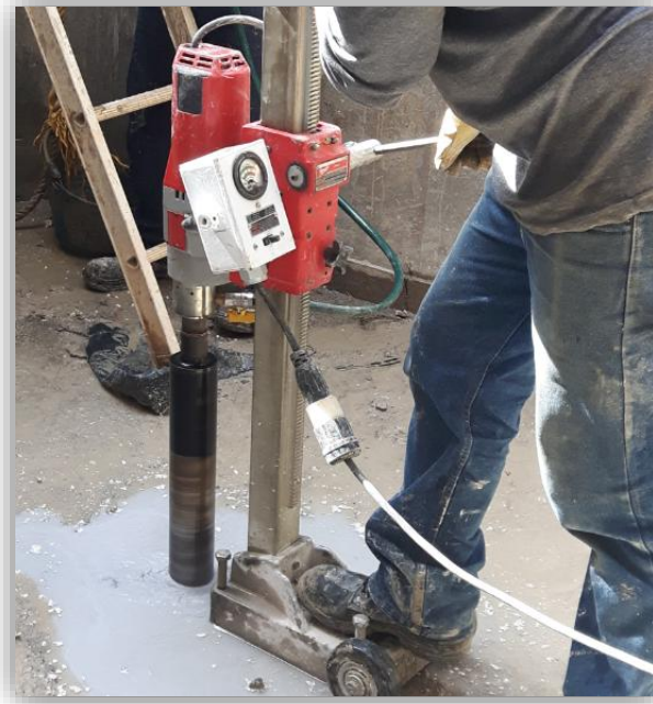
Figura 40. Extracción de núcleos
