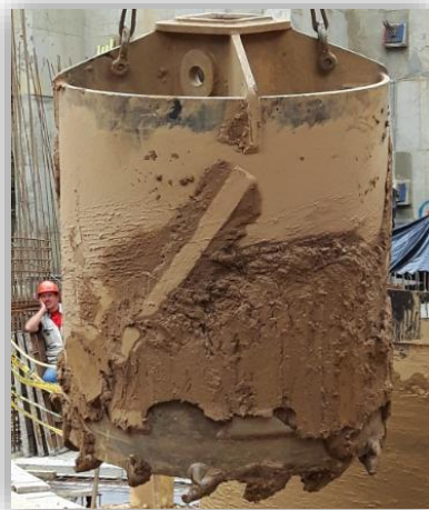
Figura 10. Carrotier de corte
