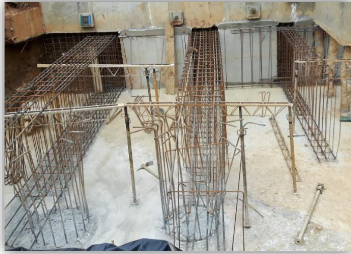
Figura 27. Armado de vigas de la placa aligerada
