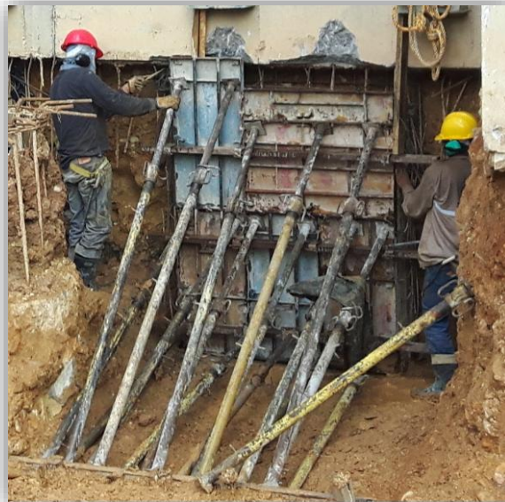
Figura 24. Armado de formaleta
