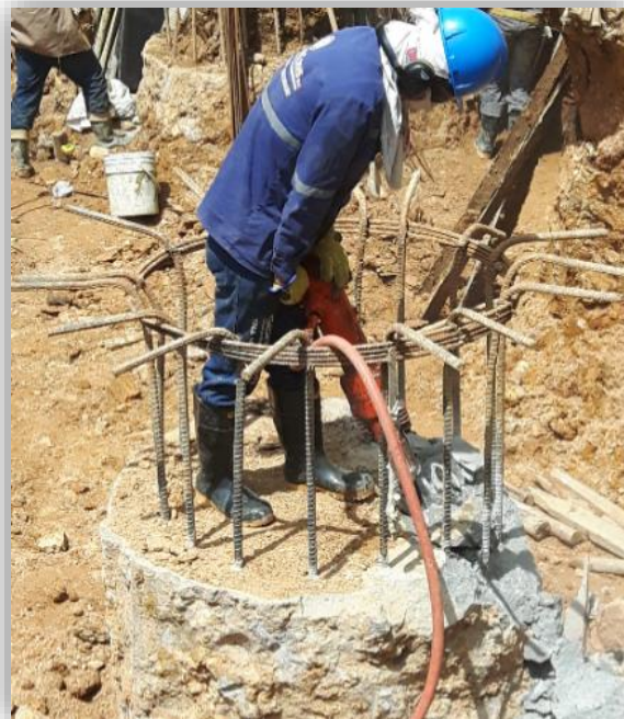
Figura 20. Descabece del pilote
