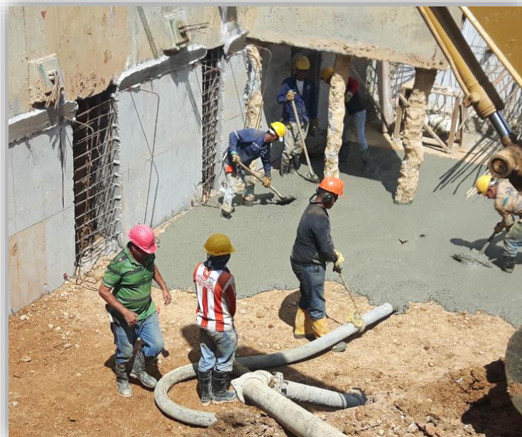
Figura 26. Vaciado concreto de limpieza
