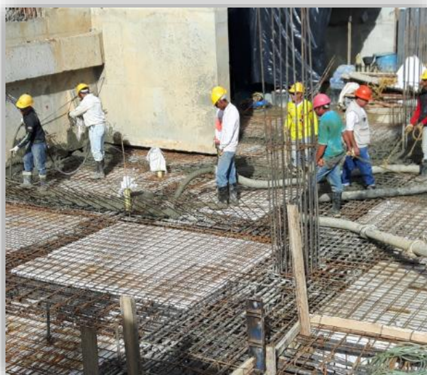
Figura 32. Descarga de concreto placa aligerada
