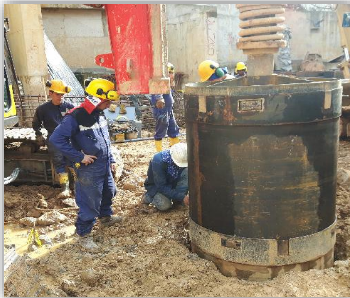
Figura 16. Acople y colocación de camisas
