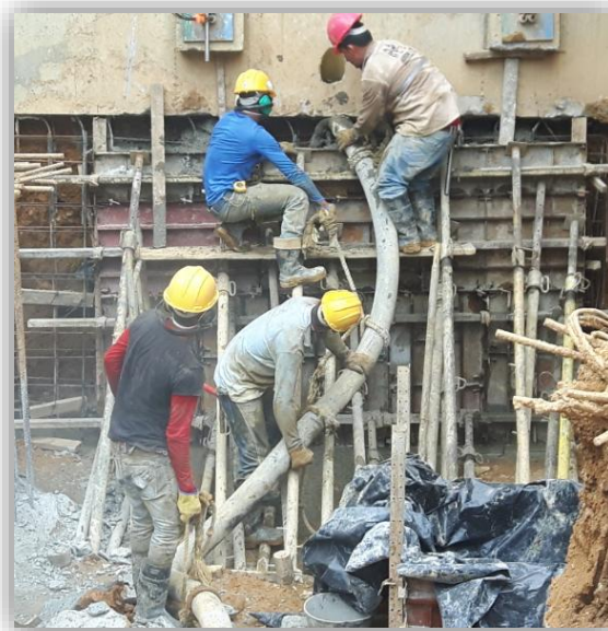
Figura 25. Vaciado concreto de muro pantalla
