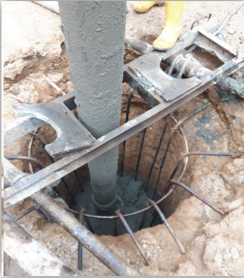
Figura 14. Vaciado del concreto
