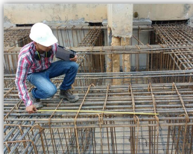
Figura 28. Verificación de traslapos y espaciamiento
