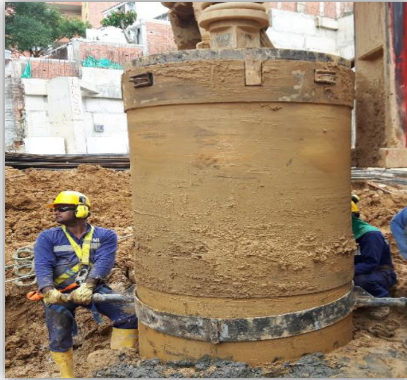
Figura 17. Extracción y desacople de camisas
