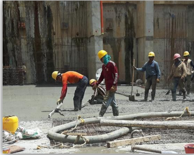
Figura 34. Corte del concreto fresco
