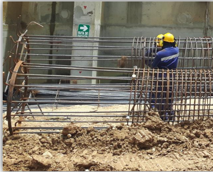
Figura 7. Armado del refuerzo
