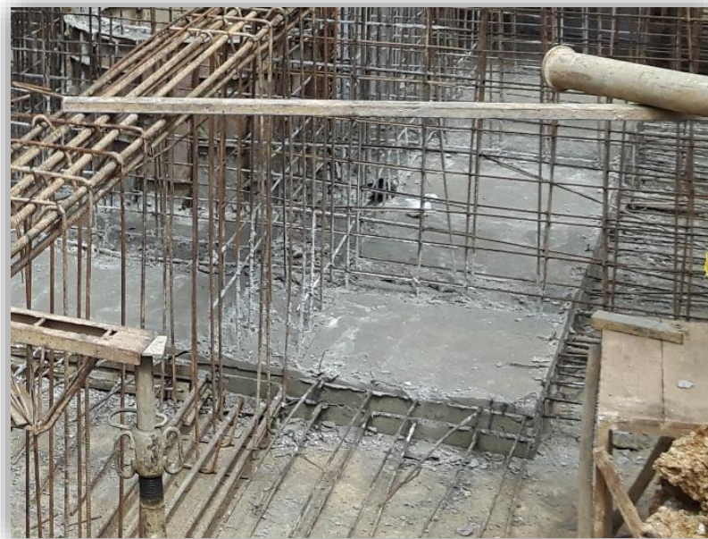
Figura 29. Torta inferior de cimentación
