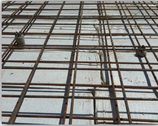
Figura 31. Distanciador entre mallas electrosoldadas
