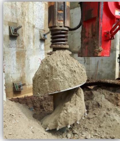
Figura 9. Barrena o espiral
