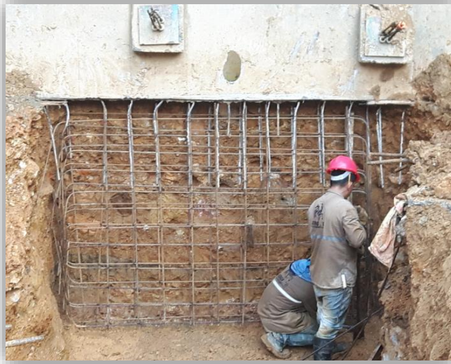
Figura 23. Armado muro pantalla
