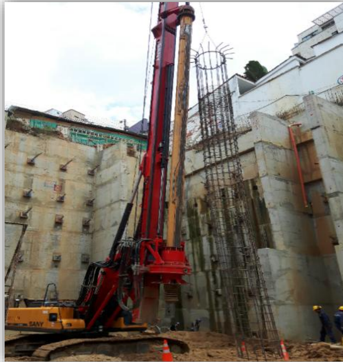
Figura 13. Colocación de la armadura de acero
