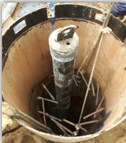
Figura 18. Colocación de refuerzo dentro del entubado
