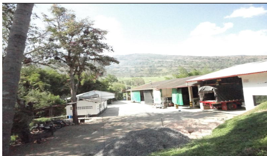
Figura 4. Instalaciones de la planta de curtido
