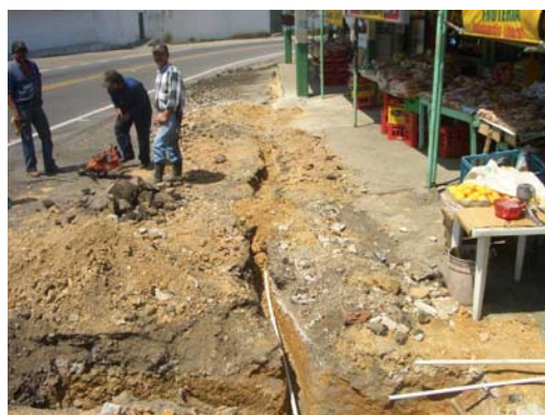
Colocación línea de conducción
