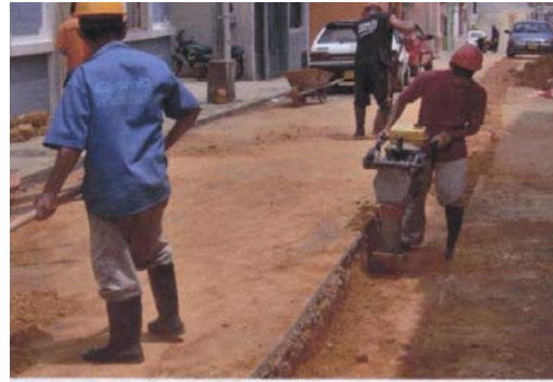
Foto 26. Compactación de Rellenos en material común
