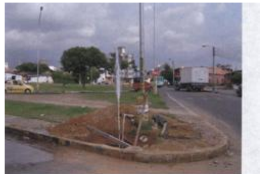
Prueba hidráulica en la Avenida Quebradaseca desde la Carrera 12 hasta la Carrera 9* (Chorro producto de la presión del agua).
