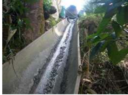
Transporte del Concreto ciclópeo
