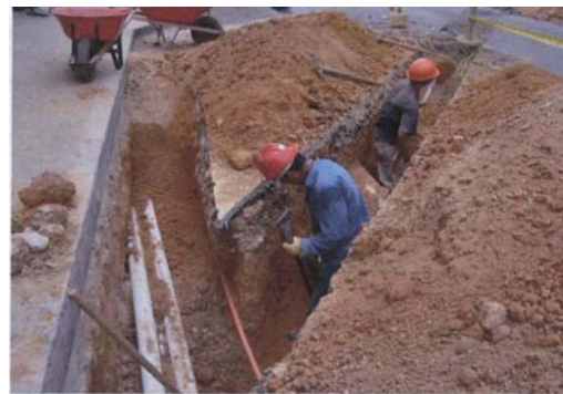
Fotos 12 y 13. Excavación en tierra y/o conglomerado
