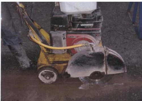
Fotos 2 y 3. Cortadora de pavimento con disco diamantado
