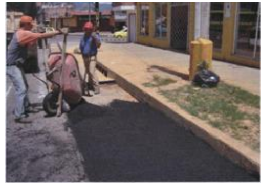
Foto 40. Aplicación de material asfáltico
