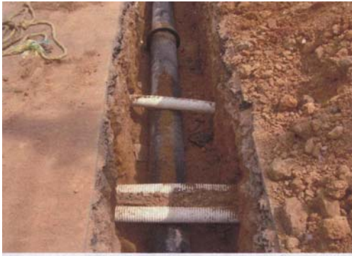
Foto 50. Instalación de tubería
