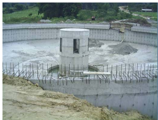
Construcción Decantadores
