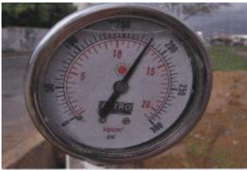
Prueba hidráulica en la Avenida Quebradaseca desde la Carrera 12 hasta la Carrera 9 (4 horas a 180 psi).
