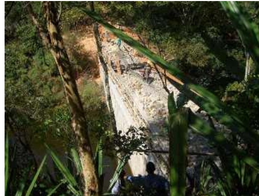
Construcción de la presa
