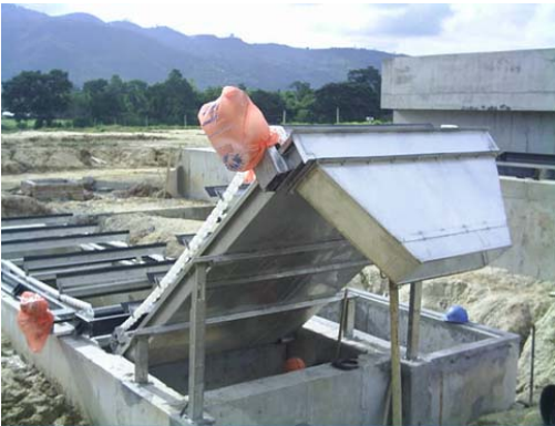
Construcción Desnatador
