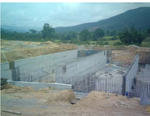
Construcción Tanques de aireación
