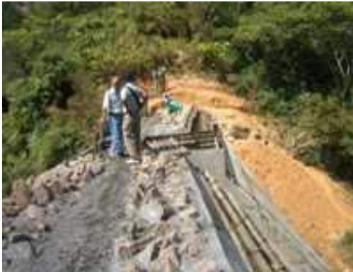
Colocación del concreto ciclópeo
