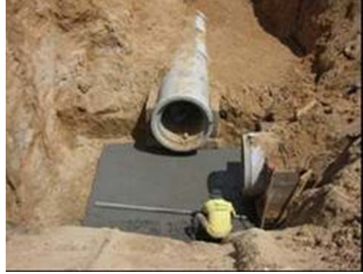
Colocación Tubería Desarenador
