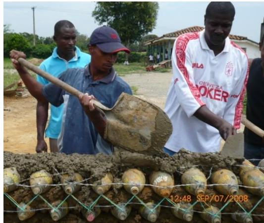
Fotografía 1: elaboración de muro con botellas de Pet recicladas
