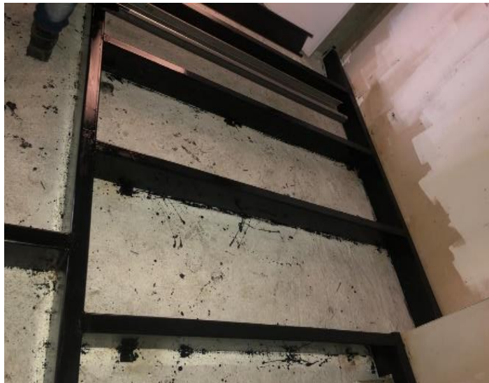
Figura 4. Aplicación de pintura anticorrosiva
