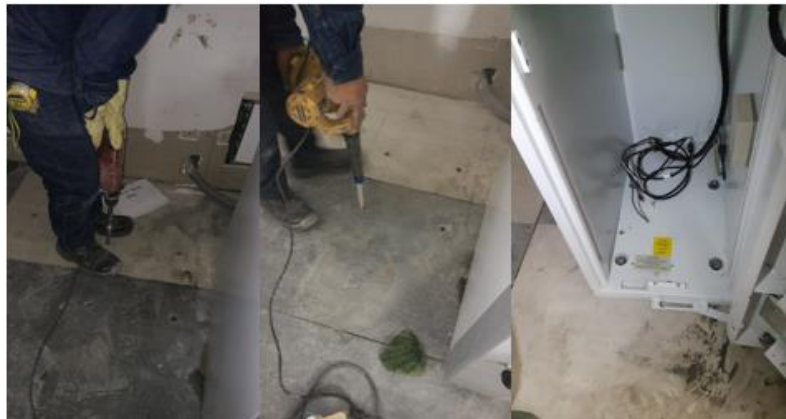
Figura 20. Anclaje de cajeros
