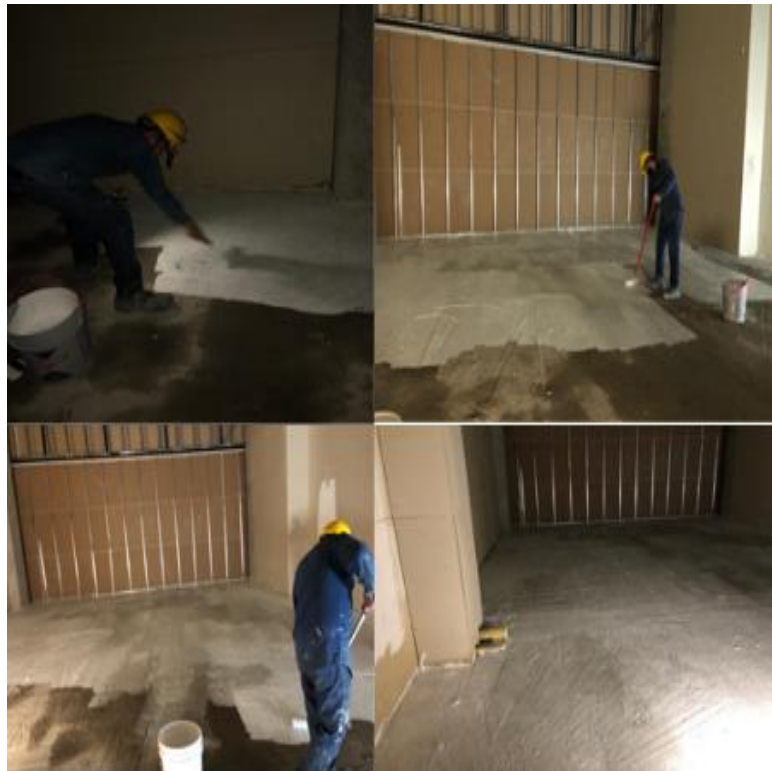
Figura 1. Impermeabilización de placa
