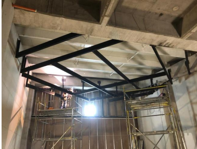
Figura 7. Montaje estructura metálica de techo
