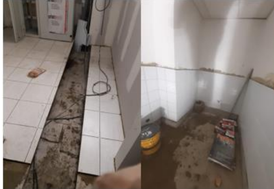
Figura 18. Enchape cuarto técnico y baño
