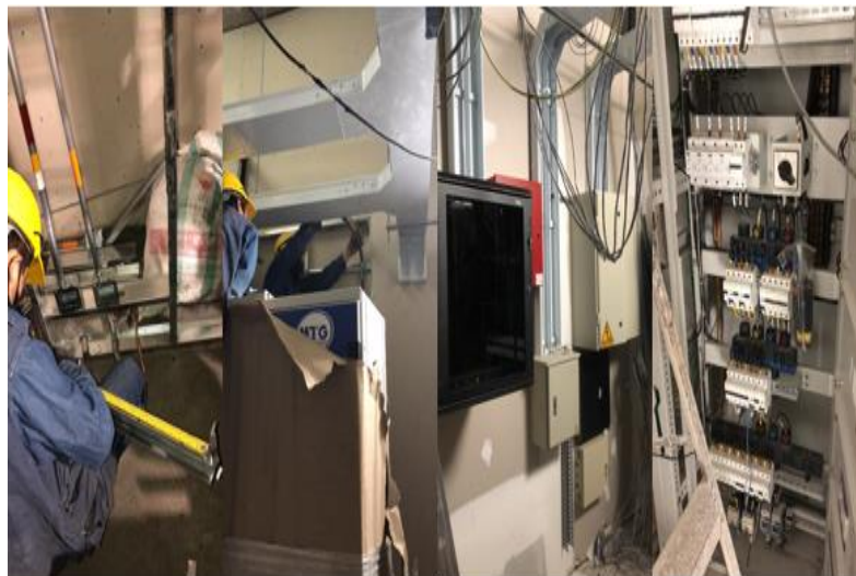
Figura 15. Instalación parte eléctrica y electrónica
