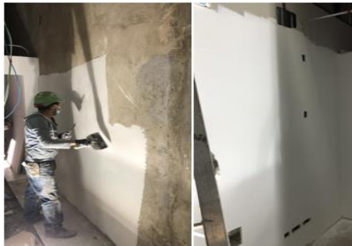
Figura 24. Pintada de muros
