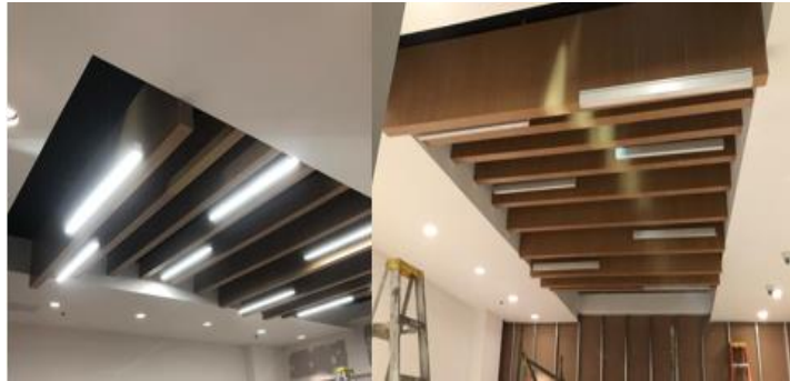
Figura 23. Perfiles de madera y luminarias
