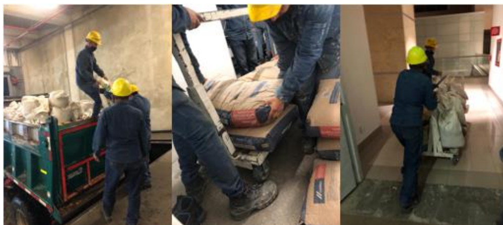
Figura 11. Ingreso del material a la obra
