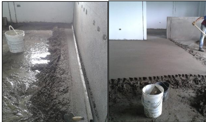
Figura 8. Mortero de nivelación.
