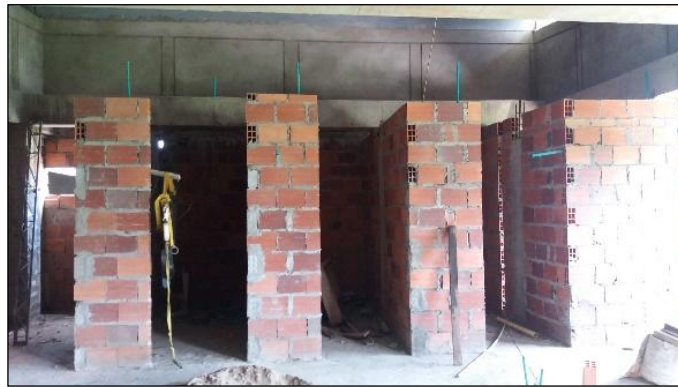
Figura 6. Muros internos en mampostería
