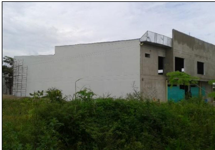
Figura 12. Graniplast en culatas
