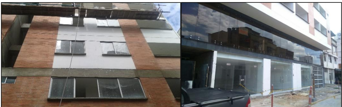
Figura 22. Fachada posterior y frontal.
