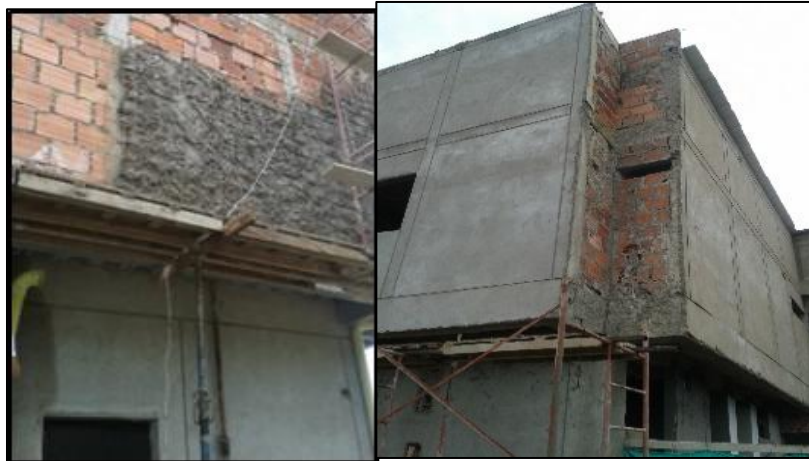
Figura 7. Friso externo impermeabilizado
