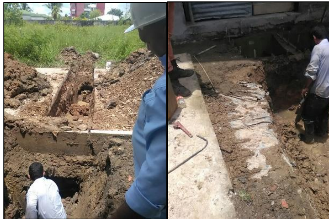
Figura 13. Conexión Alcantarillado Municipal
