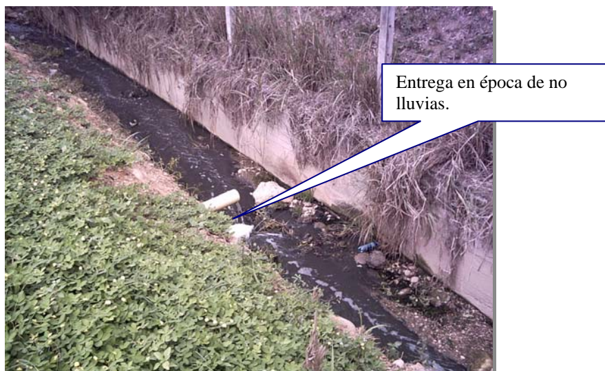
Foto 4. Inspección entrega pluvial.
