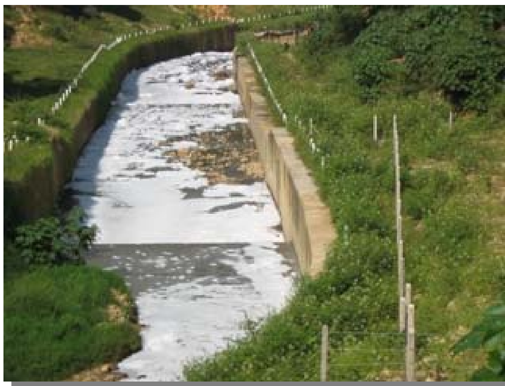
Foto 6. Panorámica canalización Quebrada la Iglesia
