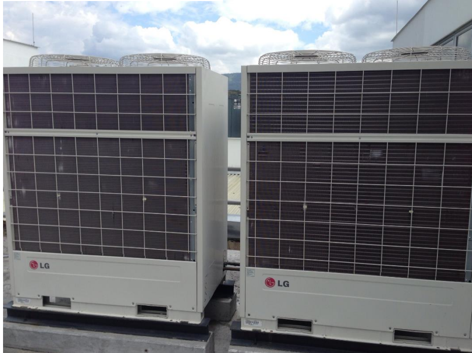
Figura 48. Condensadoras SRV marca LG.
