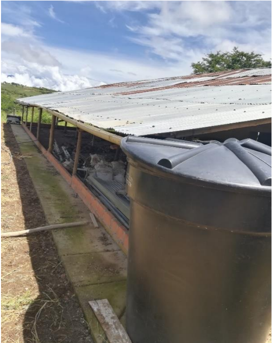
Fotografía 4. SALL vivienda vereda Garbanzal.
