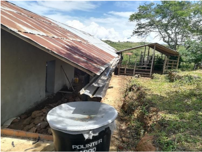
Fotografía 3. SALL vivienda vereda Garbanzal.
