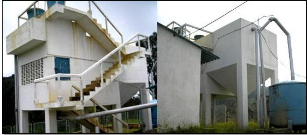
Figura 4: Panorámica de planta de tratamiento
