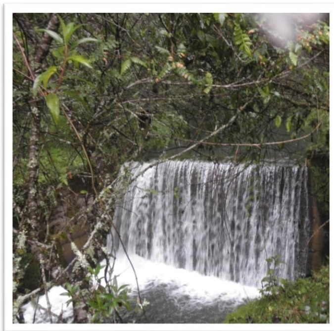
Figura 3: Bocatoma San Bartolo
