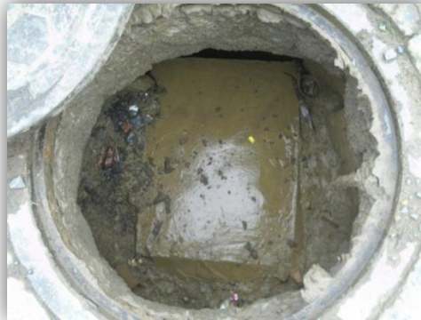
Conexión de dos redes colectoras de aguas servidas dentro de un pozo de inspección del sistema de evacuación de las aguas lluvias.
