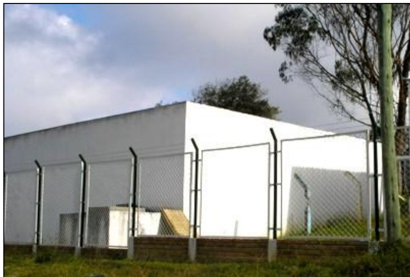
Figura 5: Tanque de almacenamiento
