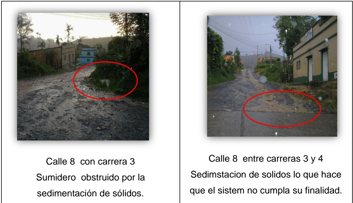
Figura 21: Sedimentación de los colectores de las redes de evacuación de aguas lluvias.
