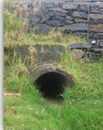
Aliviadero colector de aguas lluvias urbanización Villa campestre
