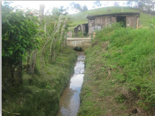
Aguas arriba del paso del agua Quebrada El Colegio, vía La ESE.
