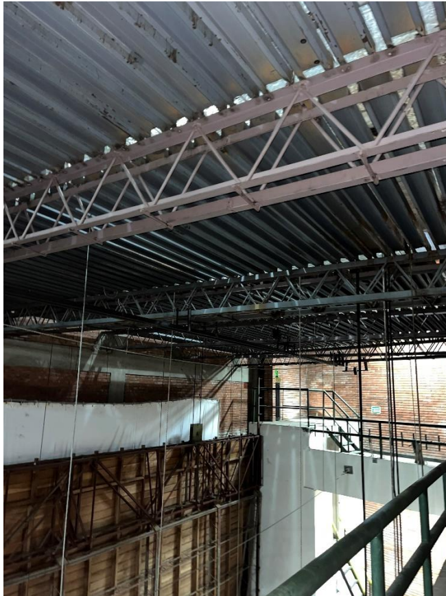
Figura 14 Estructura de la parrilla
