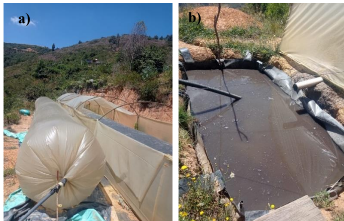
a) Biodigestor y almacenamiento de biometano, b) Pozo de salida de digerido.
