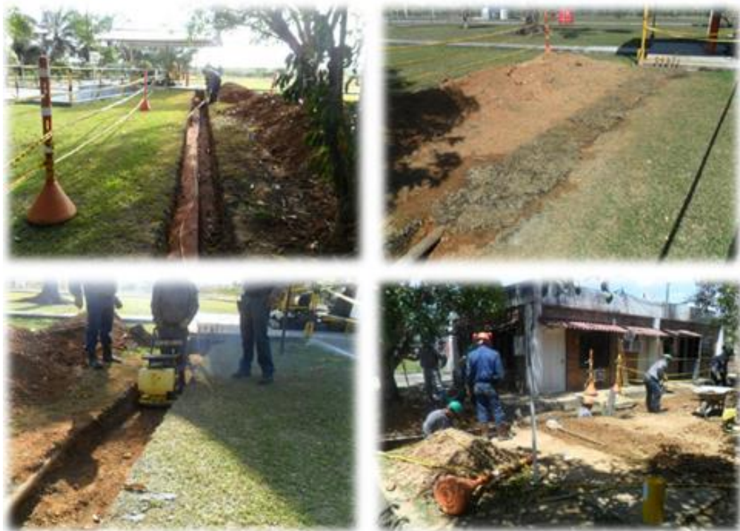
Figura 3. Registro fotográfico de algunas obras civiles realizadas por la empresa.
