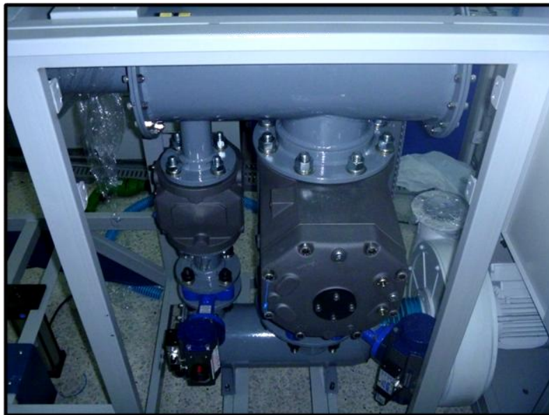
Figura 45. Montaje del módulo de patrones y el blower.
