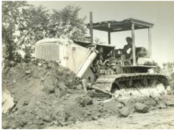
Foto 2. Mejoramiento de caminos
