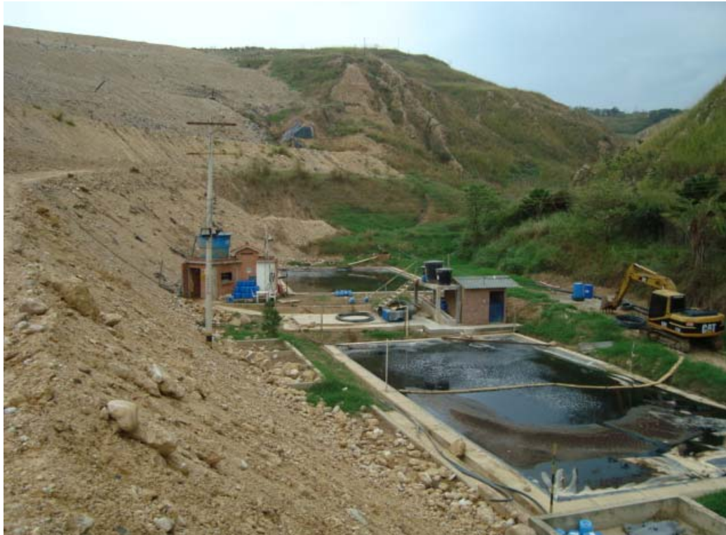
Figura 6. Planta de lixiviados en EL CARRASCO
