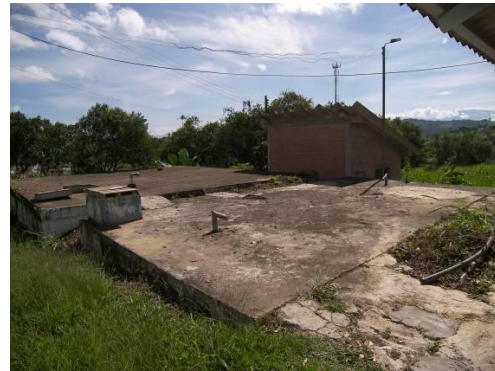
Figura 8. tanques de almacenamiento enterrados
