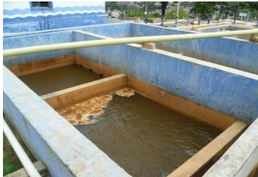
Figura 4. Unidad de mezcla lenta - floculación
