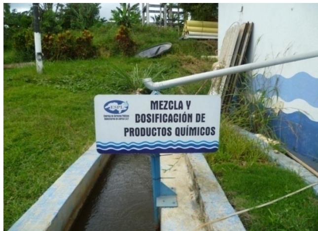
Figura 3. Mezcla y dosificación de productos químicos
