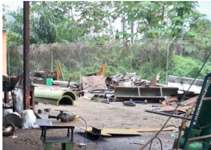
Figura 39. Acumulacion de chatarra en el taller
