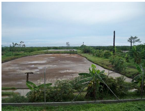
Figura 21. Lagunas de Oxidación
