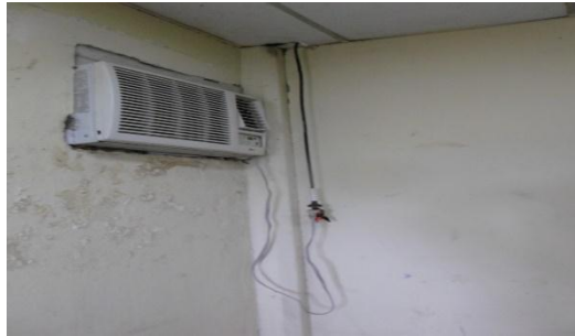
Figura 46. Instalación de aire acondicionado del cuarto de control
