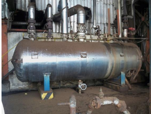
Figura 25. Distribuidor de vapor
