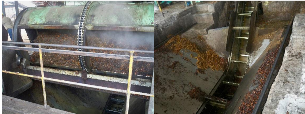
Figura 9. Tambor de volteo, tolva y transportador redler
