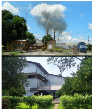
Figura 2. Planta de Producción de PALMERAS DE PUERTO WILCHES S.A.
