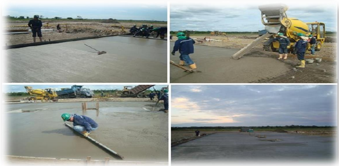
Figura 8. Placa de concreto para soporte de taladro.
