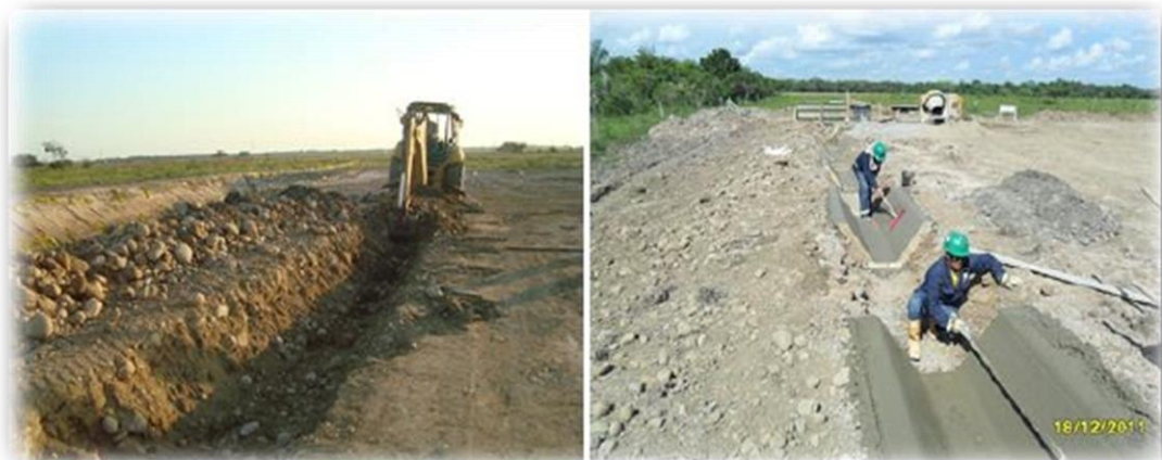
Figura 11. Excavación y vaciado del concreto
