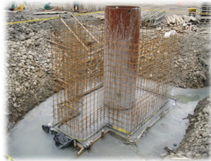
Figura 17. Estructura del contrapozo
