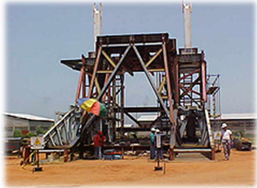
Figura 20. Estructura del contrapozo
