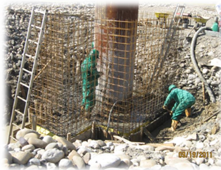
Figura 19. Estructura del contrapozo
