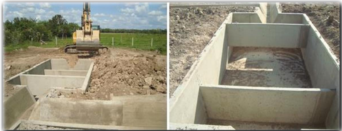
Figura 9. Construcción Skimmer típico
