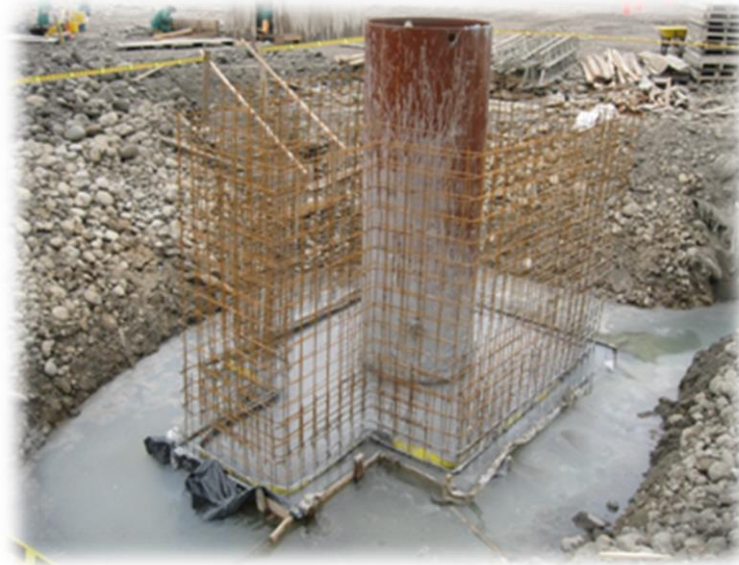
Figura 18. Estructura del contrapozo
